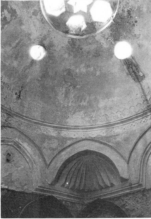
Εικ. 30. Εσωτερική άποψη ιδιωτικού λουτρού (χαμάμ) ανατολικής πτέρυγας.
