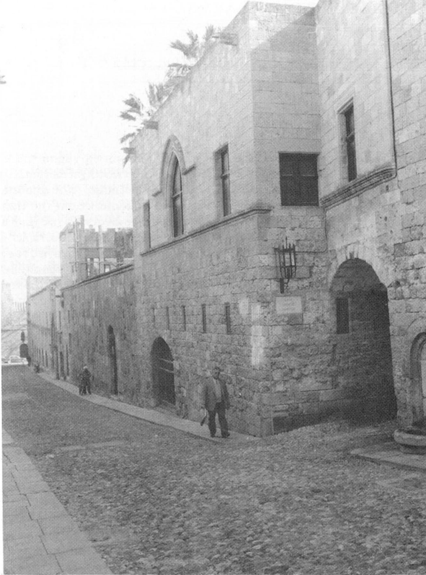
Εικ. 1. Γενική άποψη από την οδό Ιπποτών.
