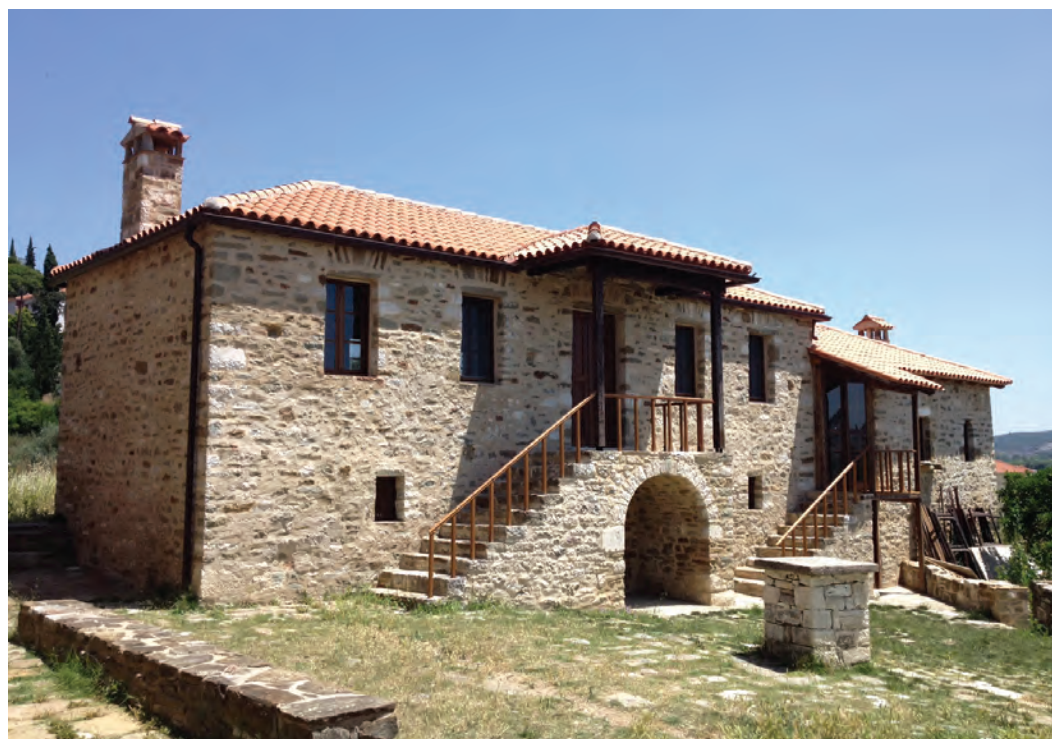
Εικ. 249. Ανατολικά κτίρια μετά τις εργασίες συντήρησης (2015).
