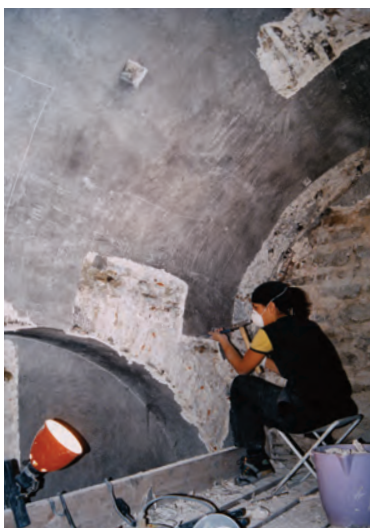
Εικ. 240. Εργασίες στερέωσης τοιχογραφιών, 2005.
