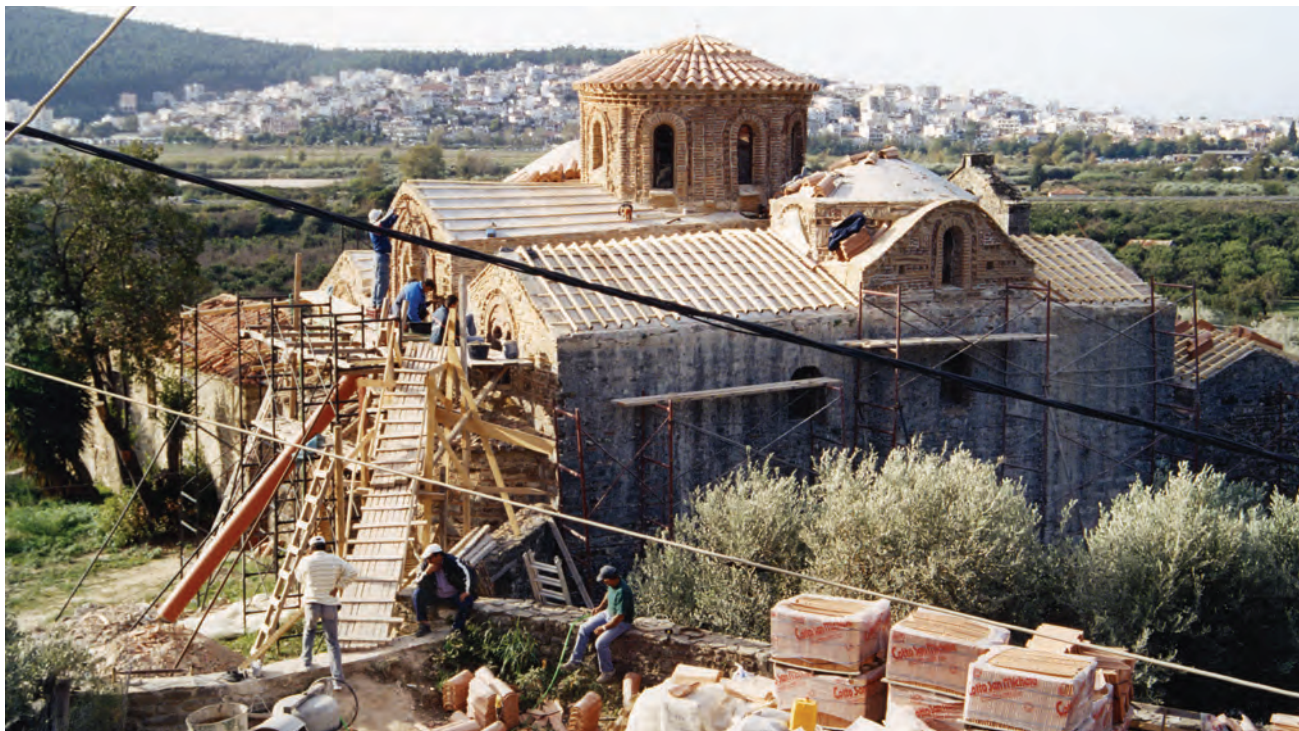
Εικ. 226α. Αποψη του ναού από βορειοανατολικά, κατά τη διάρκεια των εργασιών 2004-2006.
