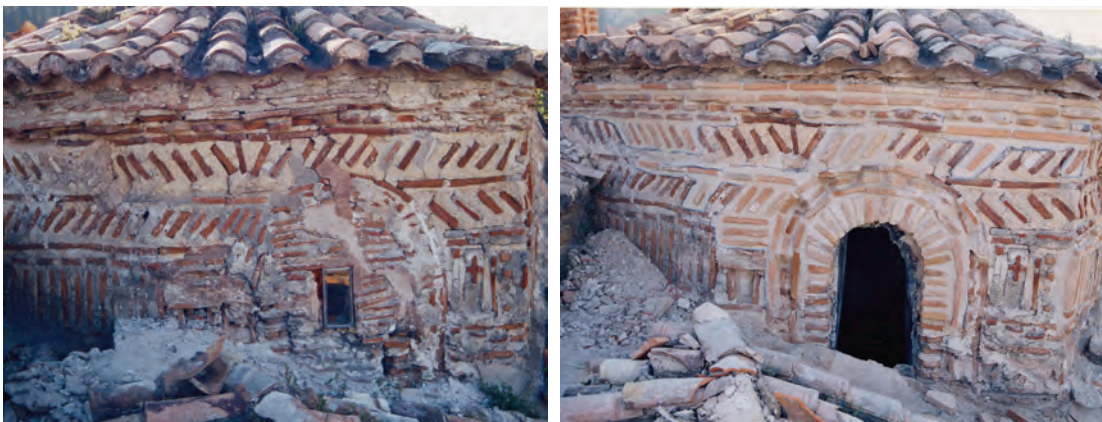
Εικ. 235 α, β. Νότιος τρούλος. Δυτική όψη κατά τη διάρκεια των εργασιών.
