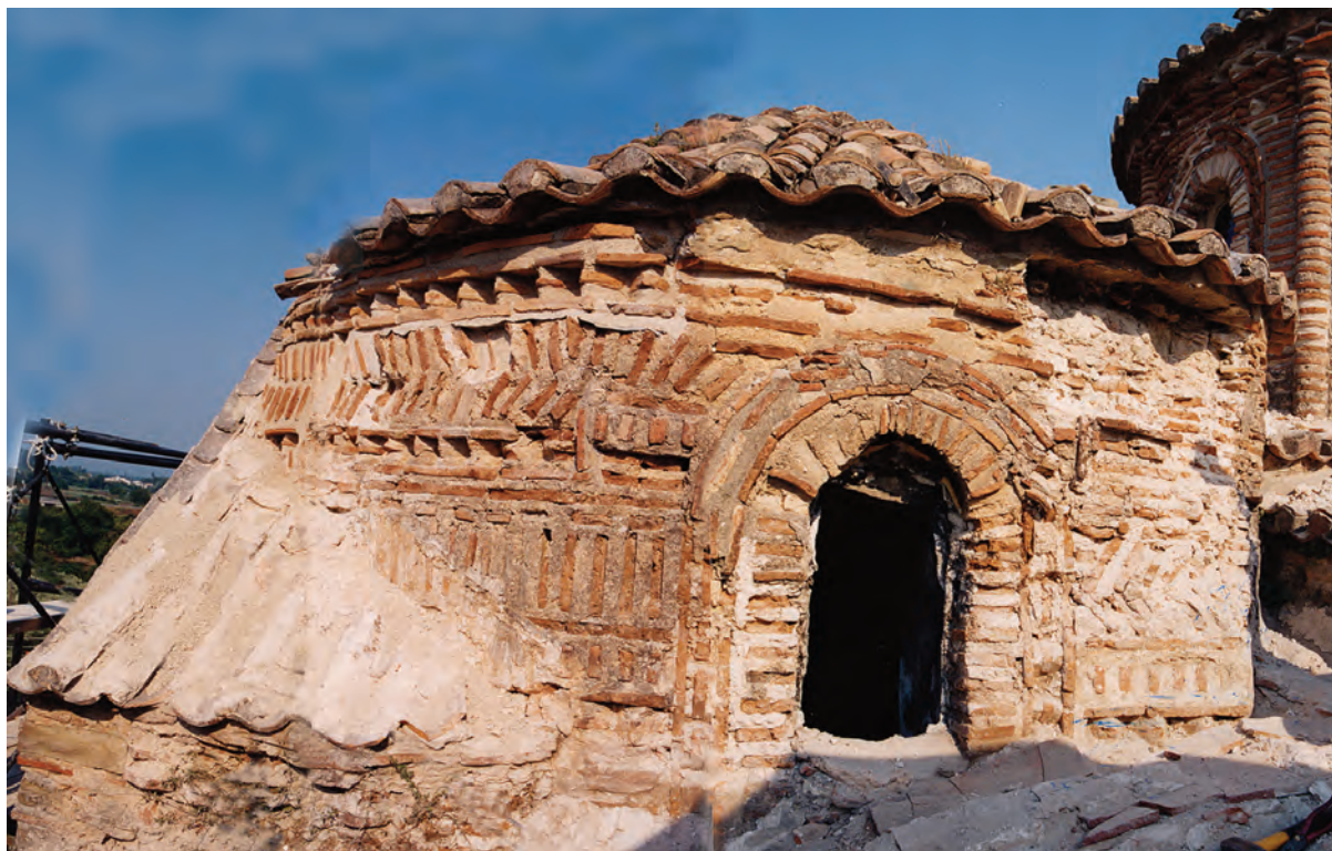
Εικ. 226β. Ο νότιος τρούλος. Κατά τη διάρκεια των εργασιών.
