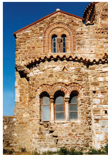
Εικ. 238. Νότια αψίδα, κατά τη διάρκεια των εργασιών.
