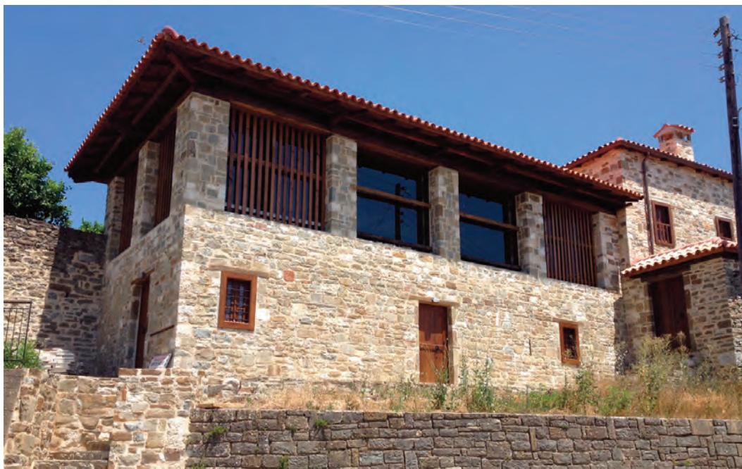
Εικ. 247. Δυτικά κτίρια. Μετά τις εργασίες συν- τήρησης (2015).
