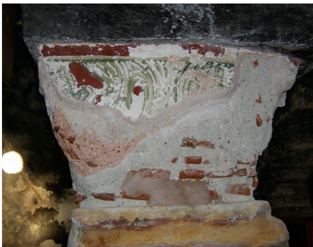
Εικ. 241 α, β. Συντήρηση αρχιτεκτονικών μελών του ναού, κατά τη διάρκεια των εργασιών.
