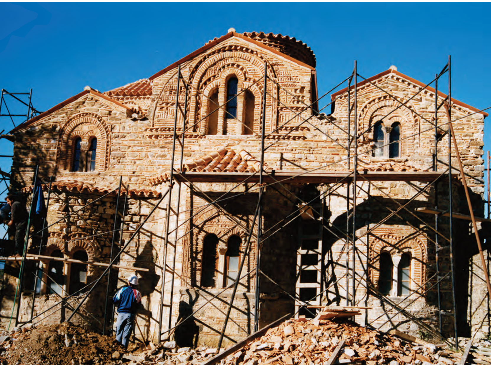
Εικ. 237. Ανατολική όψη του μνημείου, κατά τη διάρκεια των εργασιών (2004-2006).
