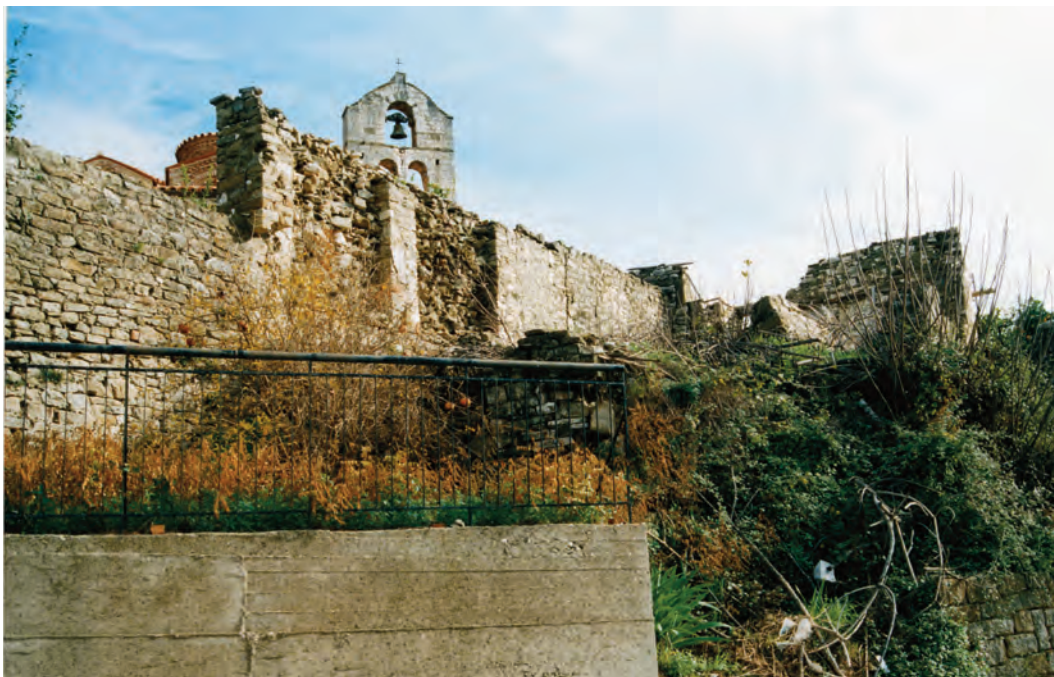
Εικ. 246. Δυτικά ερειπωμένα κτίρια. Πριν τις εργασίες συντήρησης (2011).
