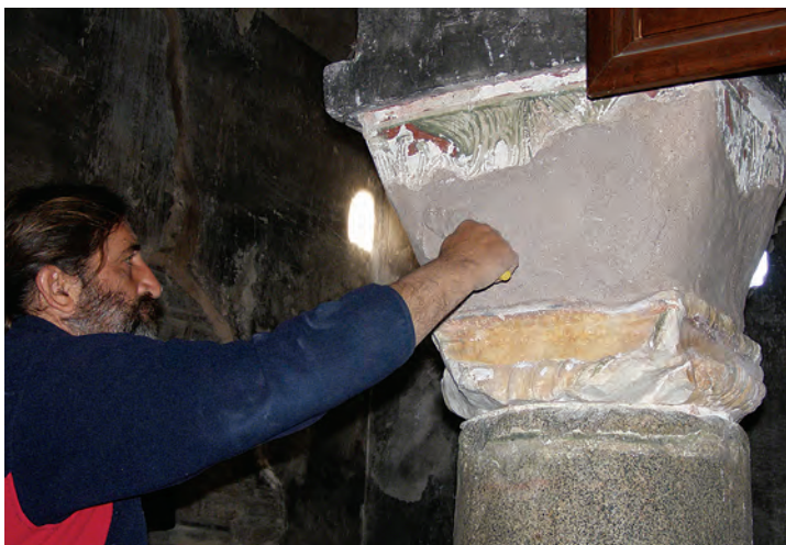
Εικ. 241 α, β. Συντήρηση αρχιτεκτονικών μελών του ναού, κατά τη διάρκεια των εργασιών.
