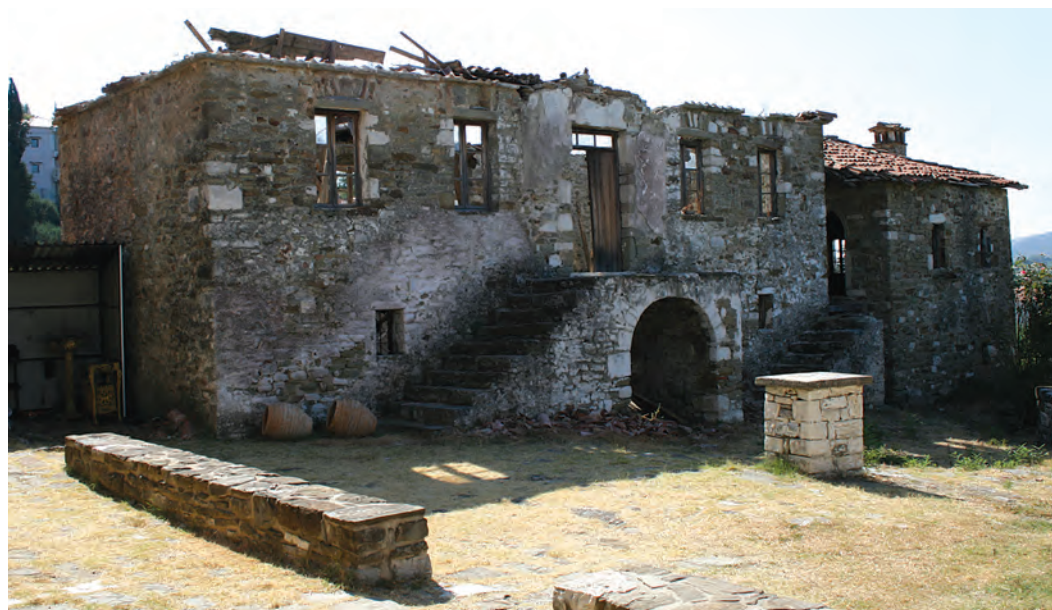
Εικ. 248. Ανατολικά κτίρια πριν τις εργασίες συντήρησης (2011).
