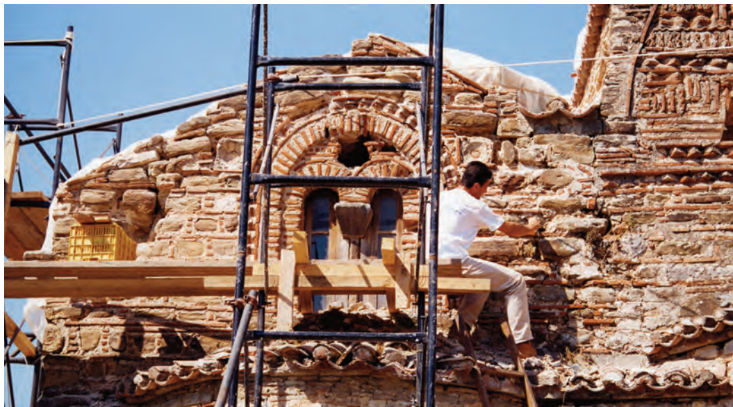
Εικ. 236. Εργασίες στα ανατολικά αετώματα.
