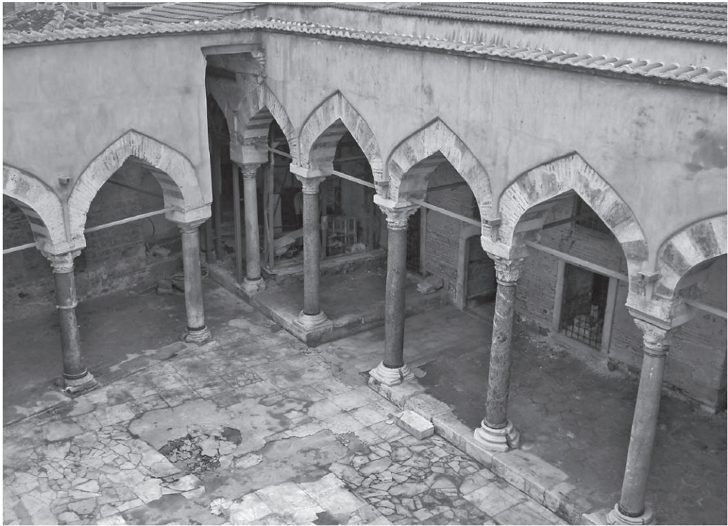
Εικ. 4. Άποψη της ΒΑ γωνίας του αιθρίου, μετά τις εργασίες ανάδειξής του.
