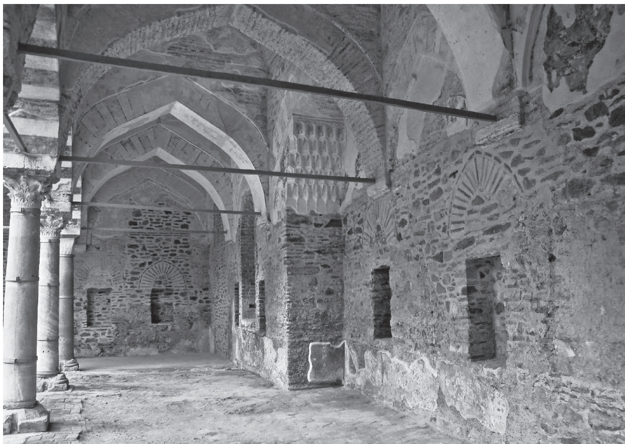
Εικ. 3. Τμήμα της βόρειας τοιχοποιίας του αιθρίου, μετά την αποκατάσταση των φθορών.
