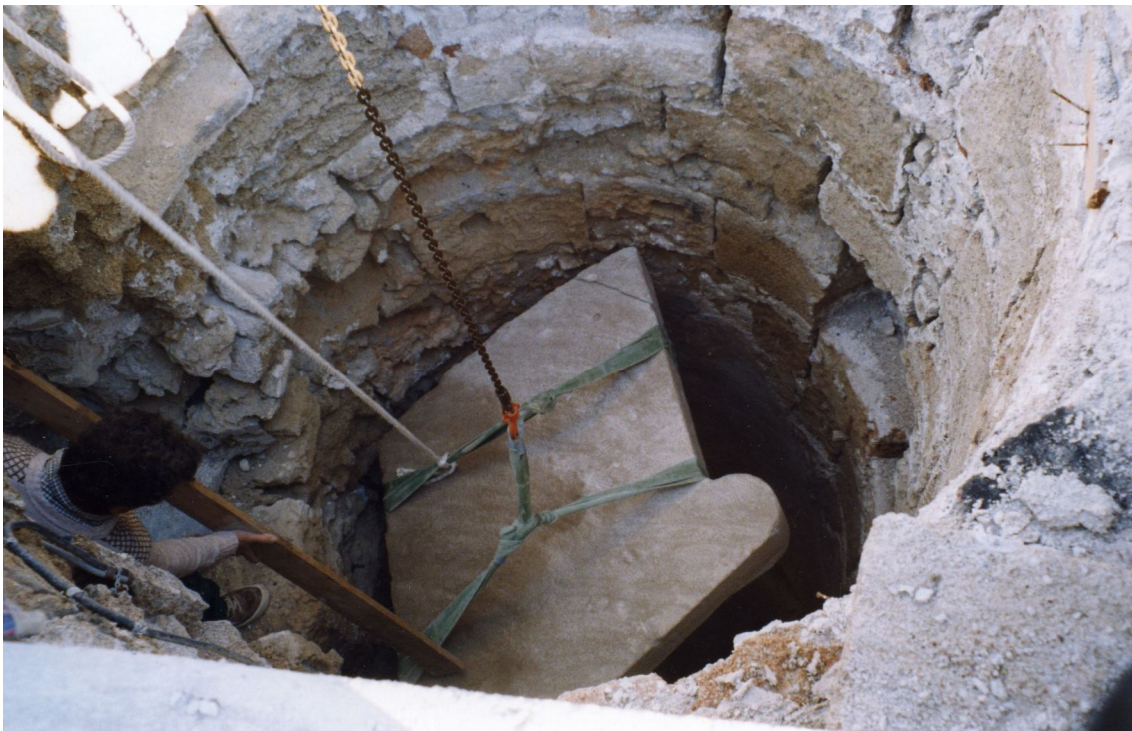
Εικ_23. Η τοποθέτηση του λίθινου πλατύσκαλου του σπειροειδούς κλιμακοστασίου.
