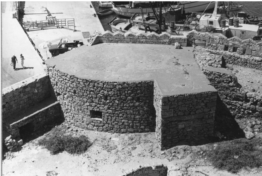
Εικ_13. Πυροβολείο ιταλικής περιόδου της νοτιοδυτικής γωνίας πριν την κατεδάφισή του που ολοκληρώθηκε το 1987.
