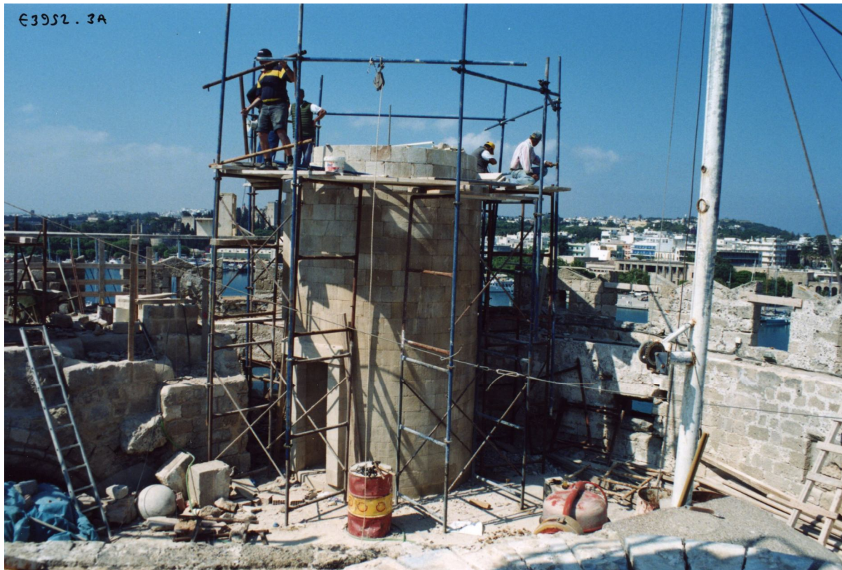
Εικ_28. Η ανακατασκευή του πέτρινου πυργίσκου στη νέα θέση.
