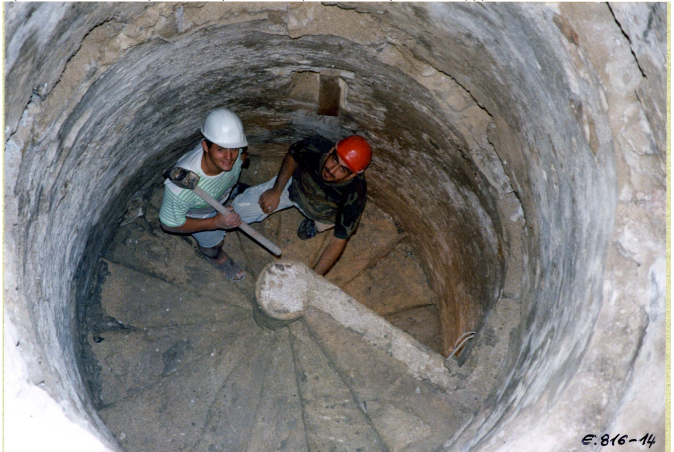
Εικ_22. Το σπειροειδές κλιμακοστάσιο κατά την αφαίρεση των σαθρών σκαλοπατιών.
