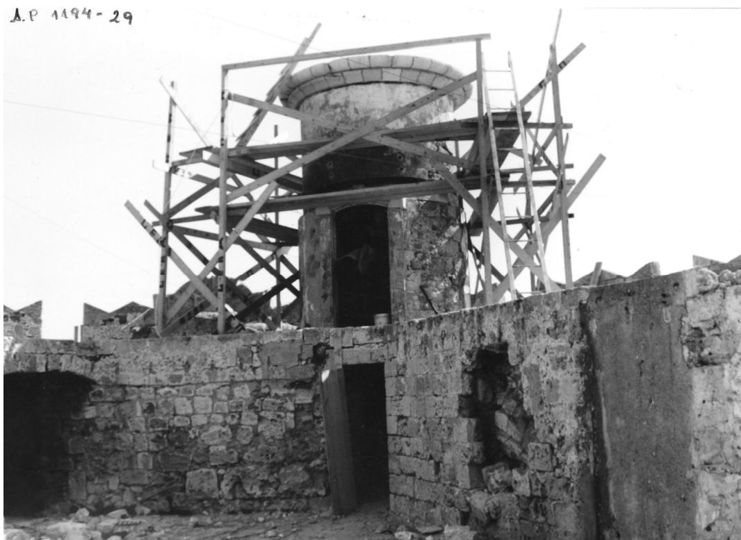
Εικ_21. Η συστηματική καθαίρεση του πέτρινου πυργίσκου του φάρου.
