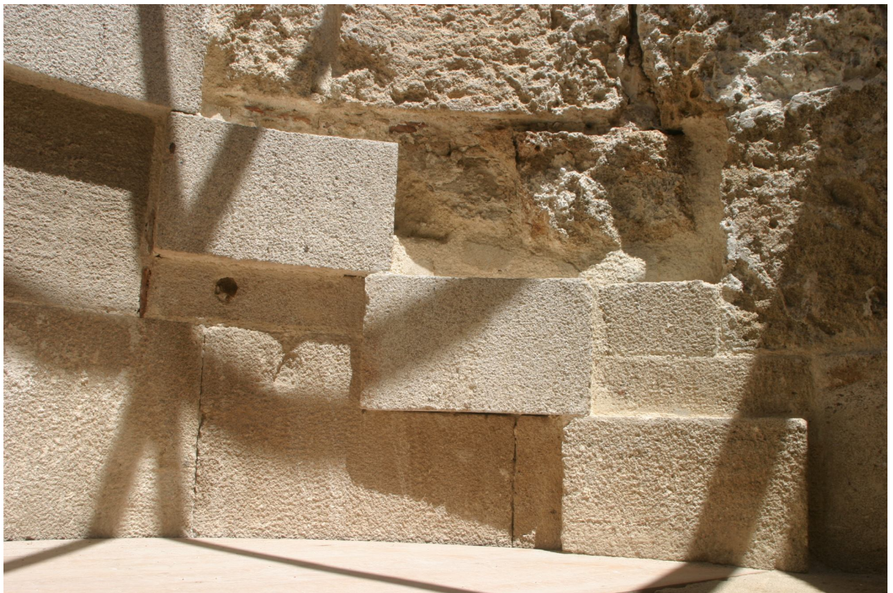
Εικ_47. Ανάδειξη ιχνών συνέχισης σπειροειδούς κλιμακοστασίου προς το δώμα της πρώτης οικοδομικής φάσης του πύργου.
