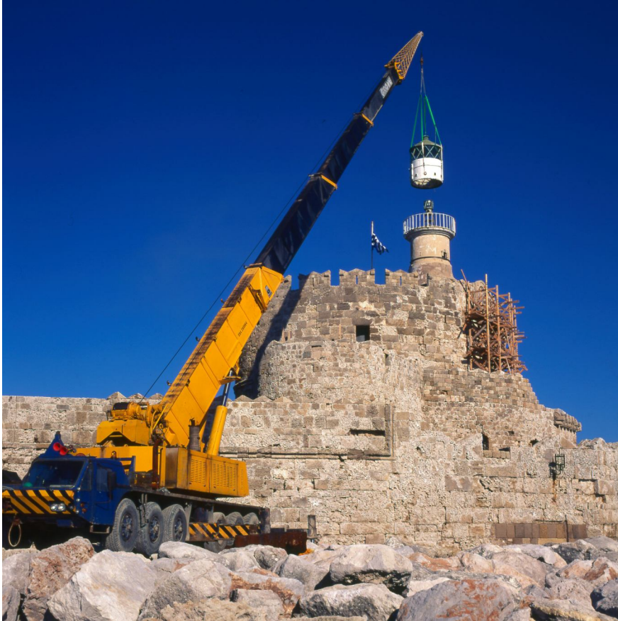
Εικ_20. Η αποσυναρμολόγηση του φάρου.
