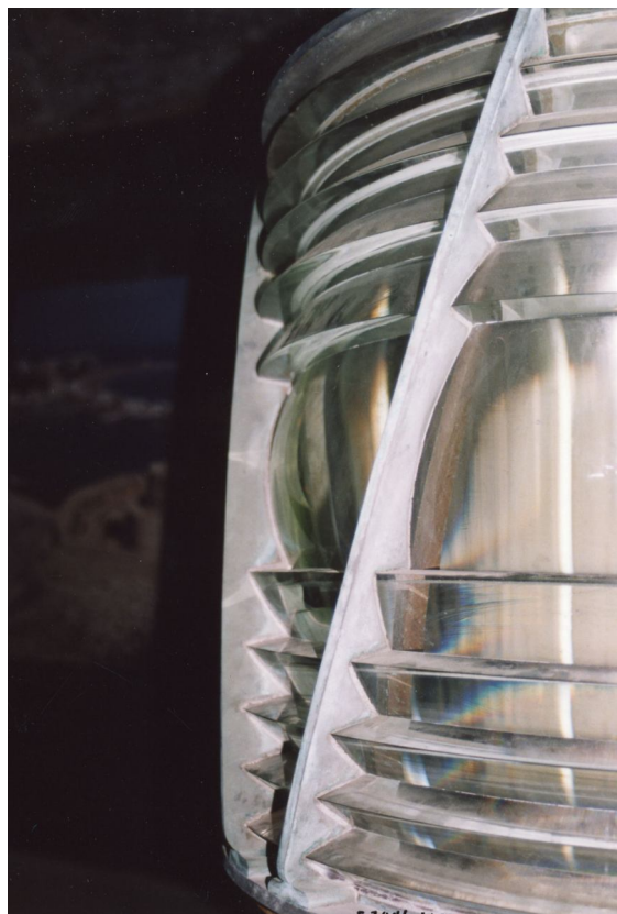
Εικ_19. Λεπτομέρεια κρυστάλλου μετά την αποσυναρμολόγηση του φάρου.
