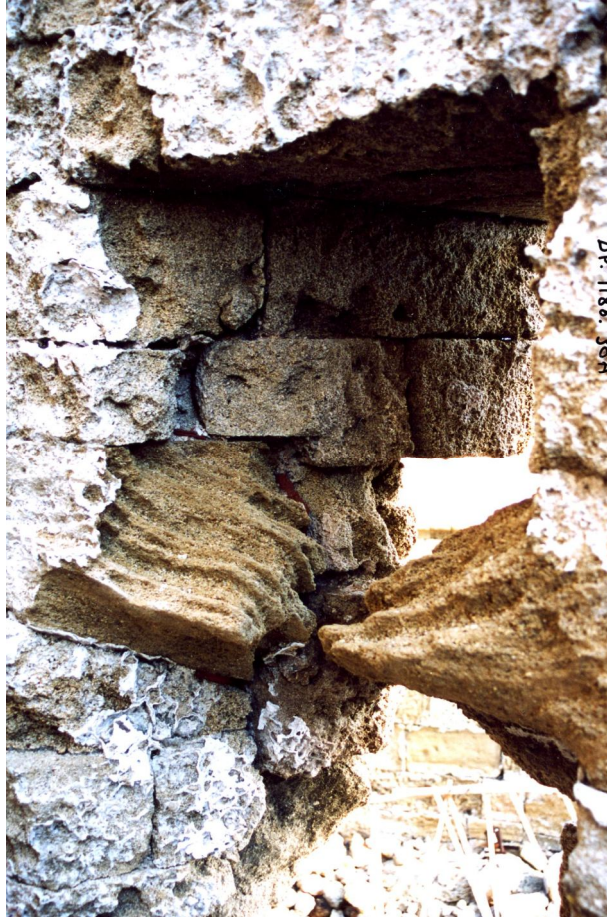
Εικ_12. Λεπτομέρεια φθοράς λίθων περιτειγίσματος Zacosta.
