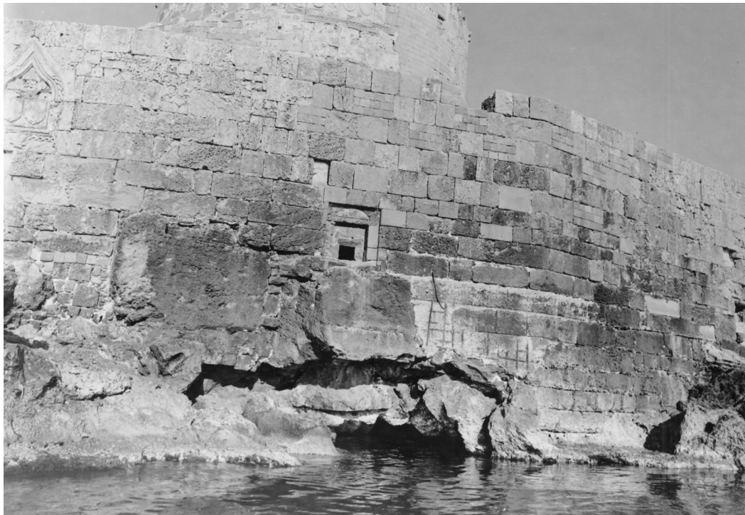
Εικ_11. Άποψη των υποσκαφών στη θεμελίωση στα νοτιοανατολικά του φρουρίου πριν την επέμβαση.
