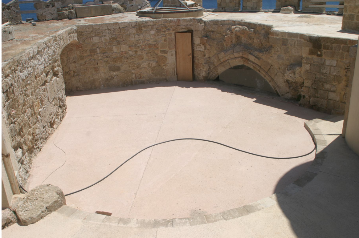
Εικ_46. Άποψη υπολειμμάτων σταυροθολίου στο δώμα του πύργου Zacosta μετά τη διαμόρφωση
