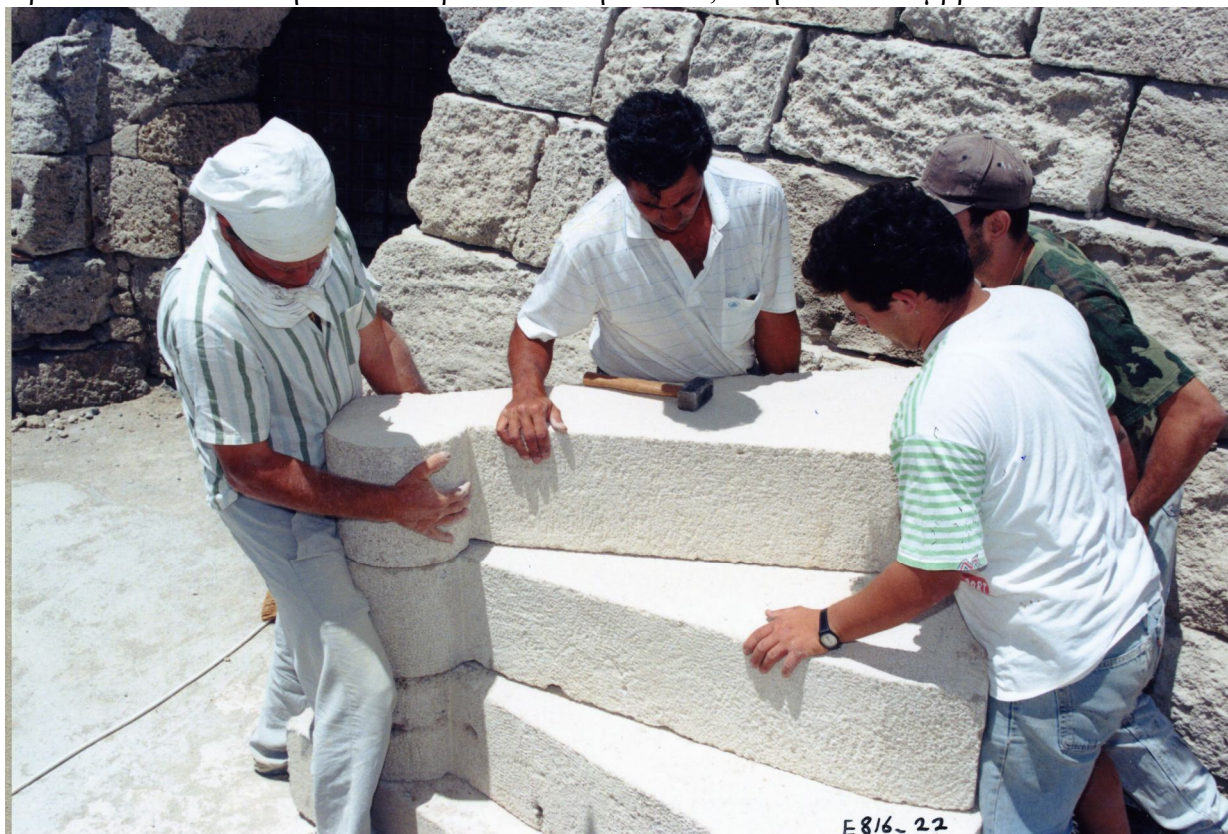
Εικ_24. Η ανακατασκευή των «σφηνοειδών σκαλοπατιών» με παραδοσιακή λάξευση λίθων.
