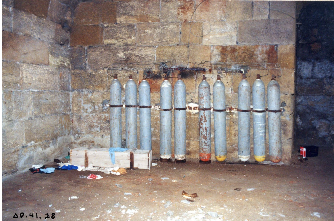
Εικ_18 .Οι φιάλες ασετιλίνης για τη λειτουργία του φάρου στον ισόγειο χώρο του πύργου.
