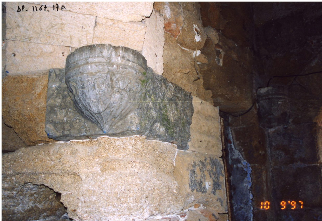
Εικ_03. Μαρμάρινη κονσόλα στήριξης αρχικού σταυροθολίου στην αίθουσα του ορόφου του πύργου Zacosta.
