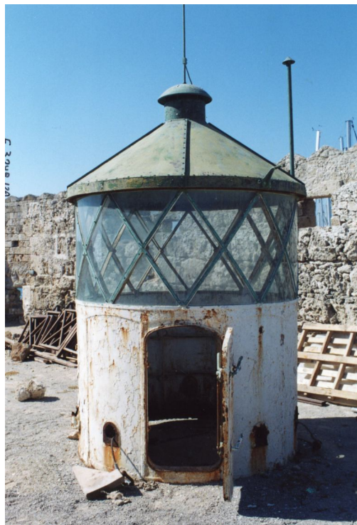
Εικ_17. Ο μεταλλικός κλωβός του φάρου πριν την συντήρηση.
