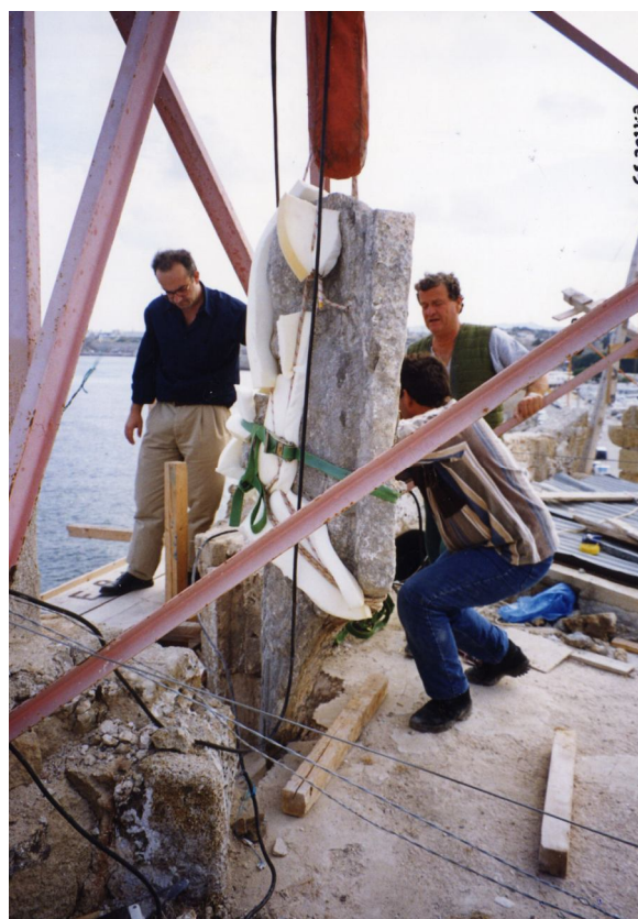
Εικ_25. Η αφαίρεση του ανάγλυφου του Αγίου Νικολάου κατά την επέμβαση συντήρησης.
