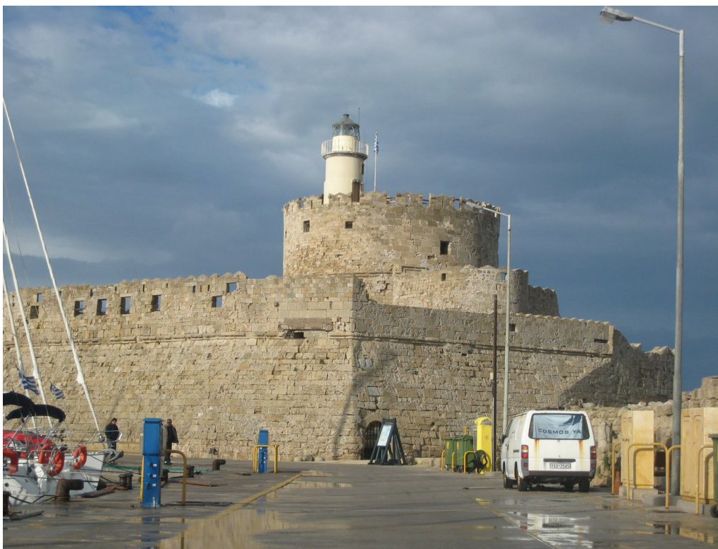
Εικ_30. Το φρούριο του Αγίου Νικολάου μετά την ολοκλήρωση των εργασιών (10-11-2007).
