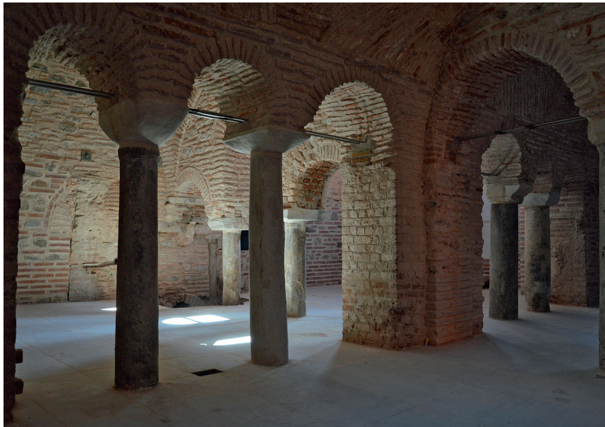
Εικ. 36. Εσωτερική άποψη του μνημείου μετά τις εργασίες στερέωσης - αποκατάστασης.
