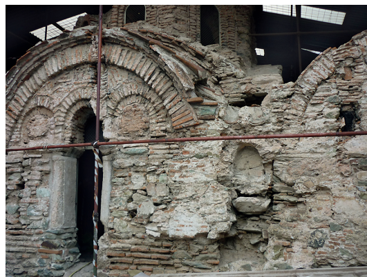
Εικ. 17. Άποψη του μνημείου πριν τις εργασίες στερέωσης - αποκατάστασης. Fig. 17. View of the monument before the restoration – consolidation project.
