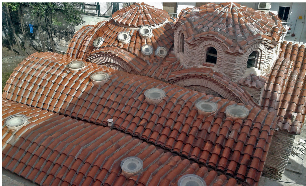
Εικ. 28. Αποψη των στεγών μετά τις εργασίες στερέωσης - αποκατάστασης. Fig. 28. View of the roof after the restoration - consolidation project.
