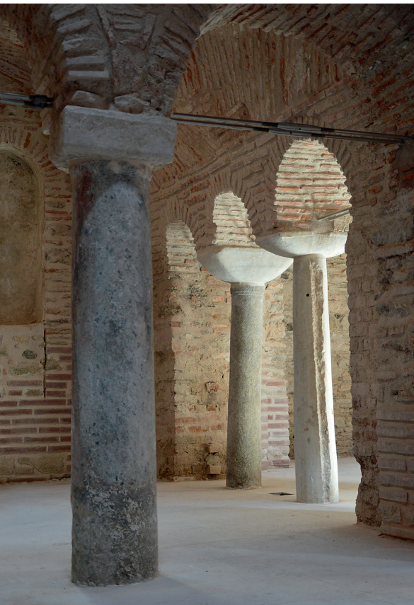
Εικ. 35. Εσωτερική άποψη του χλιαρού χώρου (χλιαροψύχριον) μετά τις εργασίες στερέωσης - αποκατάστασης.
