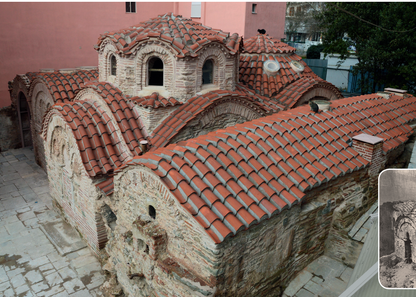
Εικ. 27. Αποψη του μνημείου από ΝΑ μετά τις εργασίες στερέωσης - αποκατάστασης.
