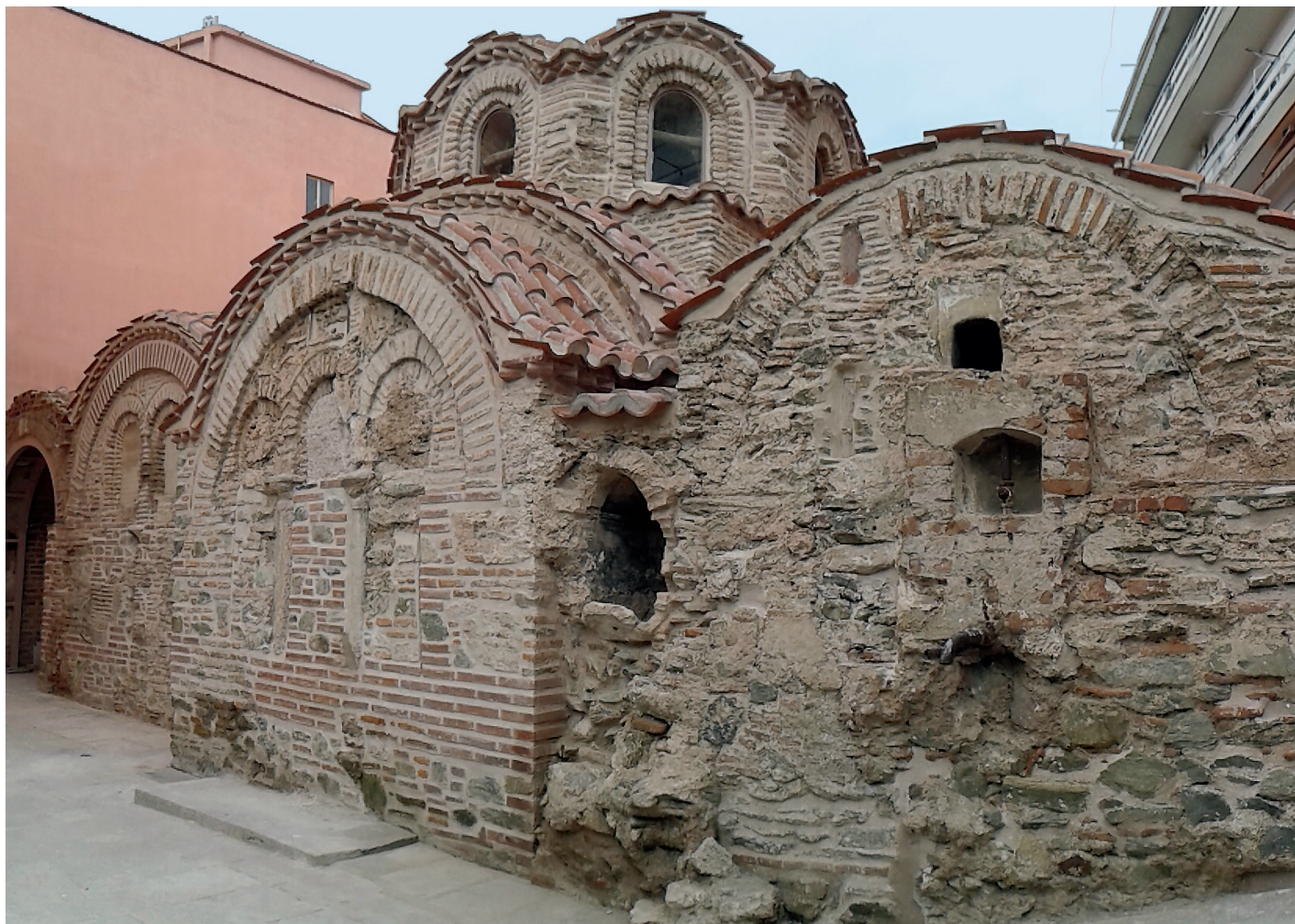
Εικ. 29. Η νότια όψη μετά τις εργασίες στερέωσης - αποκατάστασης.
