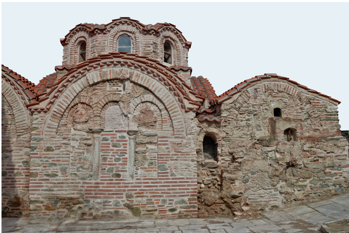
Εικ. 30. Το ανατολικό τμήμα της νότιας όψης μετά τις εργασίες στερέωσης - αποκατάστασης.
