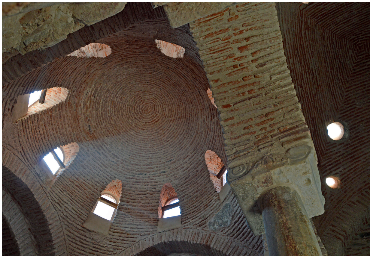
Εικ. 40. Εσωτερική άποψη της θολωτής ανωδομής του θερμού χώρου.
