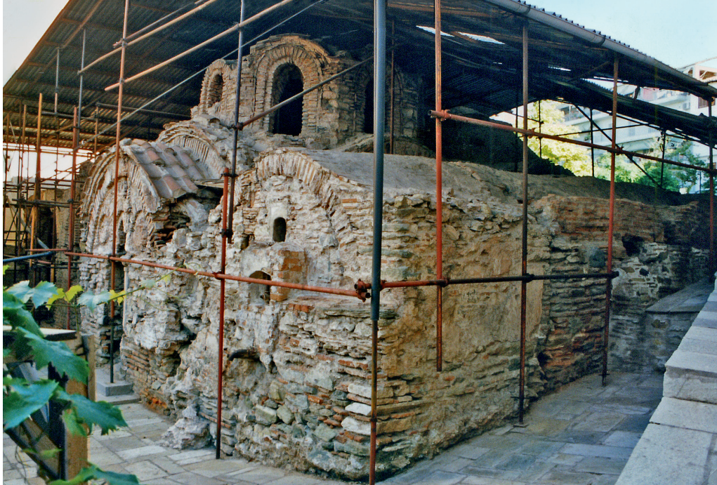
Εικ. 15. Άποψη του μνημείου πριν τις εργασίες στερέωσης - αποκατάστασης. Fig. 15. View of the monument before the restoration – consolidation project.
