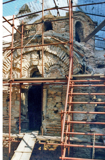
Εικ. 16. Άποψη του μνημείου πριν τις εργασίες στερέωσης - αποκατάστασης. Fig. 16. View of the monument before the restoration – consolidation project.
