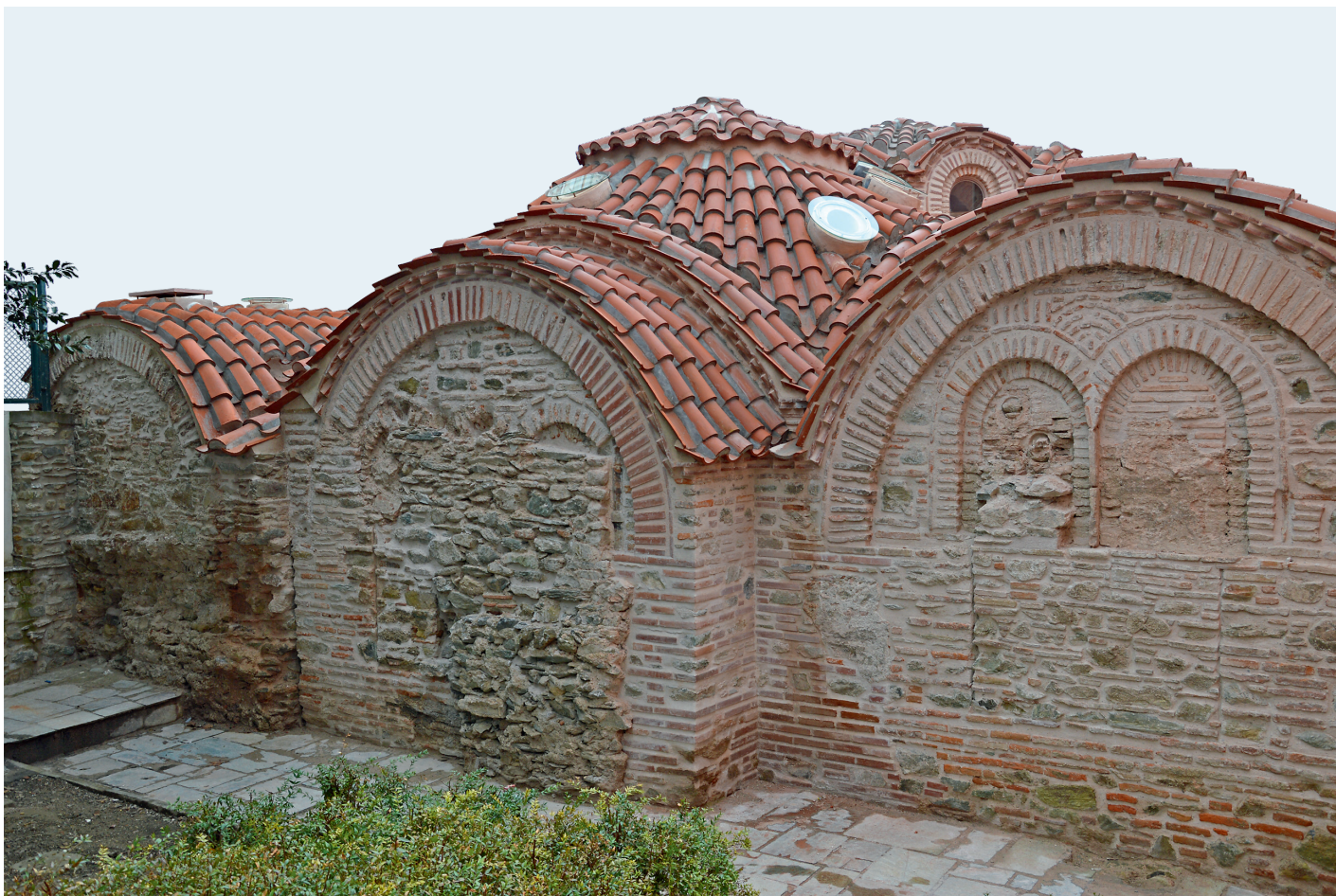
Εικ. 31. Η βόρεια όψη μετά τις εργασίες στερέωσης - αποκατάστασης.
