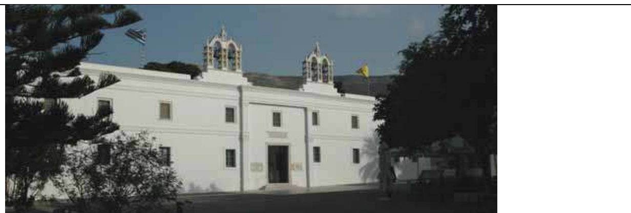
Εικ. 38. Πρόσοψη του περιβάλλου μετά την εγκατάσταση των κωδωνοστασίων
