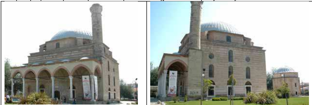
Εικ. 21-22. Αποψη του τζαμιού μετά την ολοκλήρωση των έργων.
