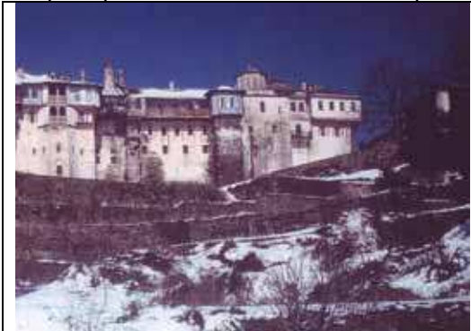
Εικ.11. Νότια Οψη πριν την πυρκαϊά.
