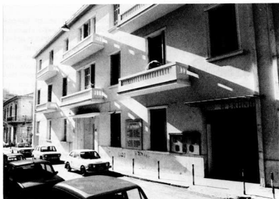
1. Το θέατρο της οδού Κυκλάδων α. Εξωτερική όψη. 8. Ο Χώρος πριν και μετά από την επέμβαση
