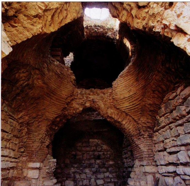
Η στέγηση των ορόφων στον πύργο του Πυθίου.
