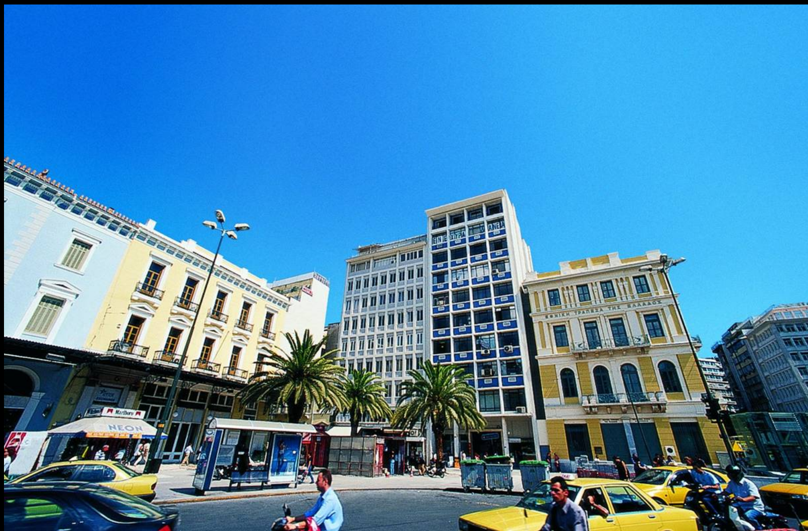
Αποκατάσταση όψεων κτηρίων Πλατεία Ομονοίας
