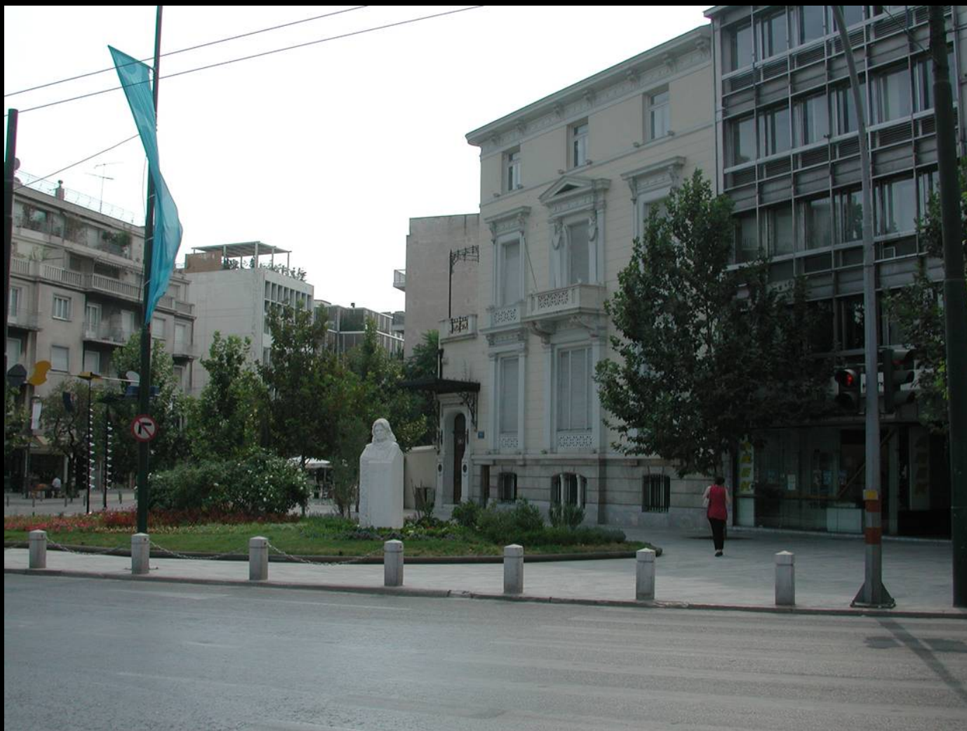
Πεζόδρομος οδού Διονυσίου Αρεοπαγίτου
