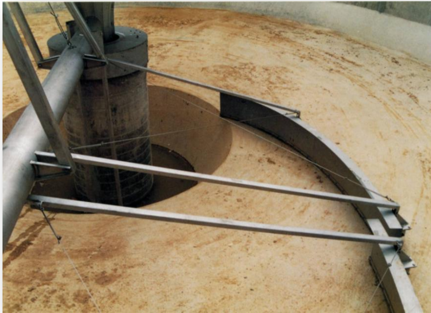
Είσοδος κώνου συγκέντρωσης ιλύος και σάρωτρο (ξέστρο) πυθμένα
