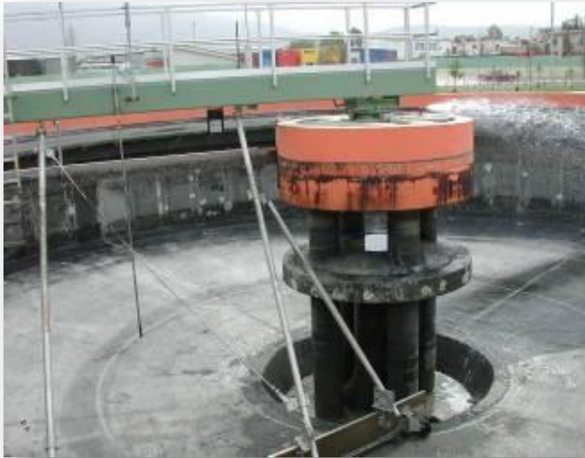
Είσοδος κώνου συγκέντρωσης ιλύος και βάση στήριξης γέφυρας
