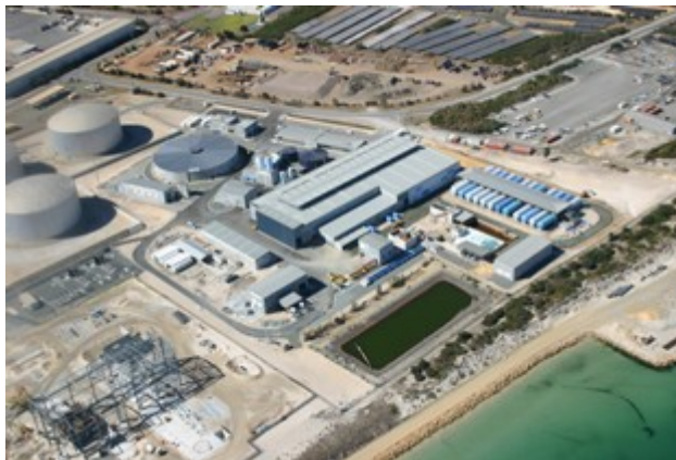
Σχήμα 44: Αεροφωτογραφία από το εργοστάσιο αφαλάτωσης στο Περθ της Δυτικής Αυστραλίας
