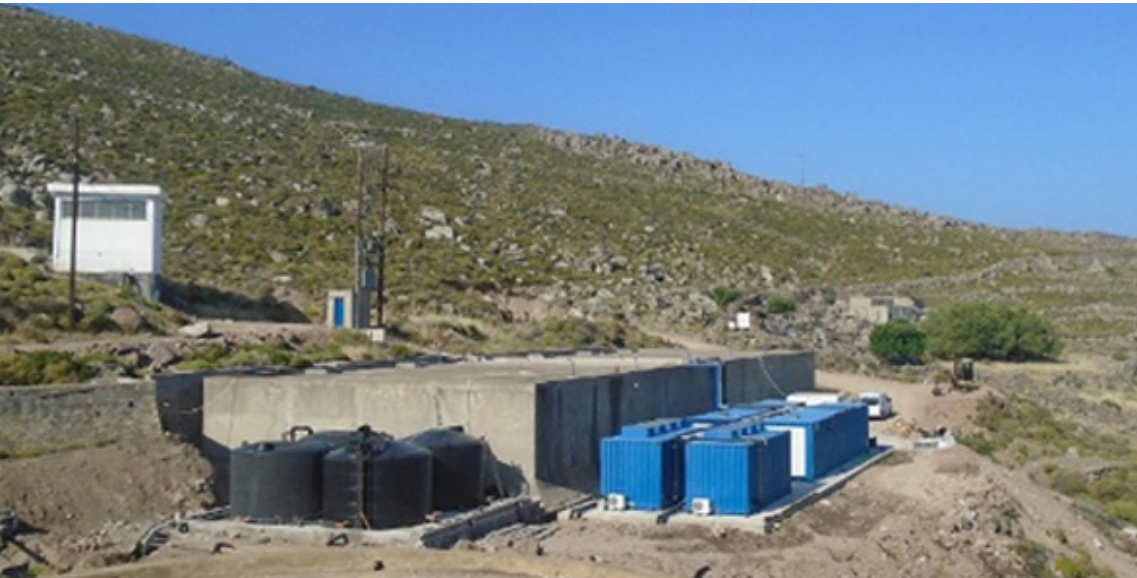
Μονάδα αφαλάτωσης στην Πάτμο | Πηγή: www.patmos.gr
