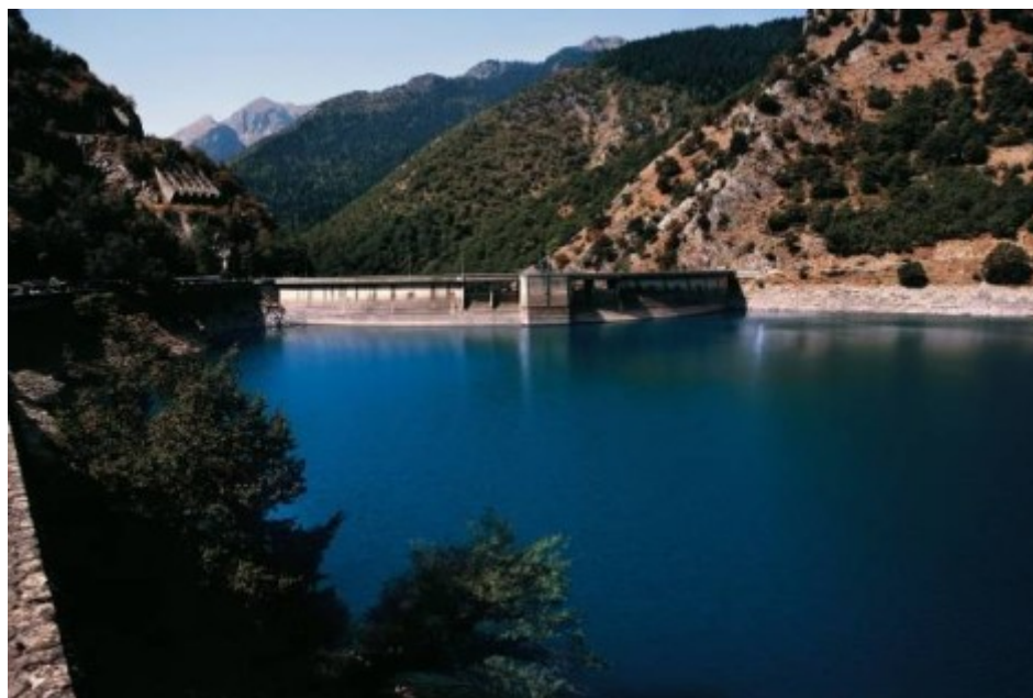
Εικόνα 5 Το φράγμα στη Λίμνη Καρδίτσας, στη Θεσσαλία
