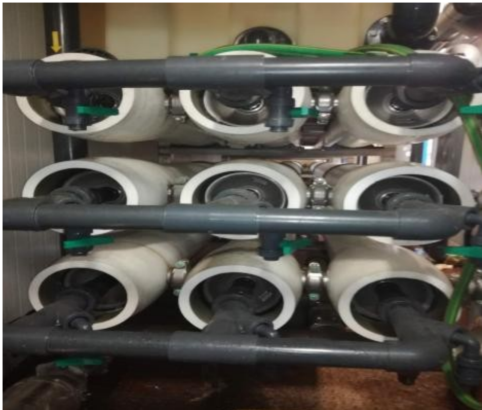
Εικόνα 7.1.3 Φωτογραφίες από συστοιχία αφαλάτωσης στη Μονάδα της Χίου
