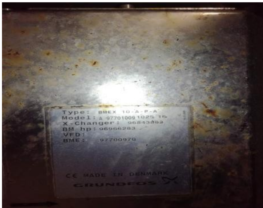
Εικόνα 7.2.11 Πιεστικό συγκρότημα της μονάδας αφαλάτωσης της Χίου τύπου BMEX (30-20, 132 K)
