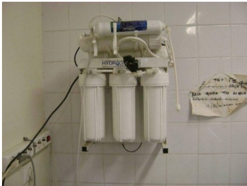
Εικόνα 27: Διάταξη Αντίστροφης Ωσμωσης των 5 σταδίων.
