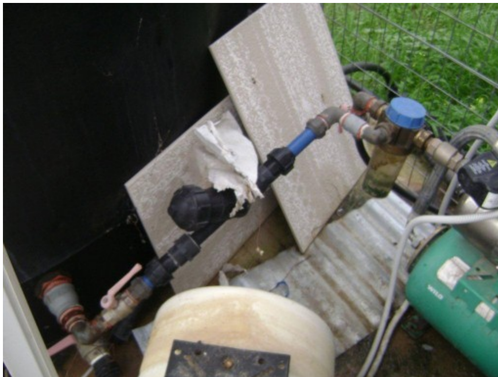
Εικόνα 20: Φίλτρο στερεών σωματιδίων.
