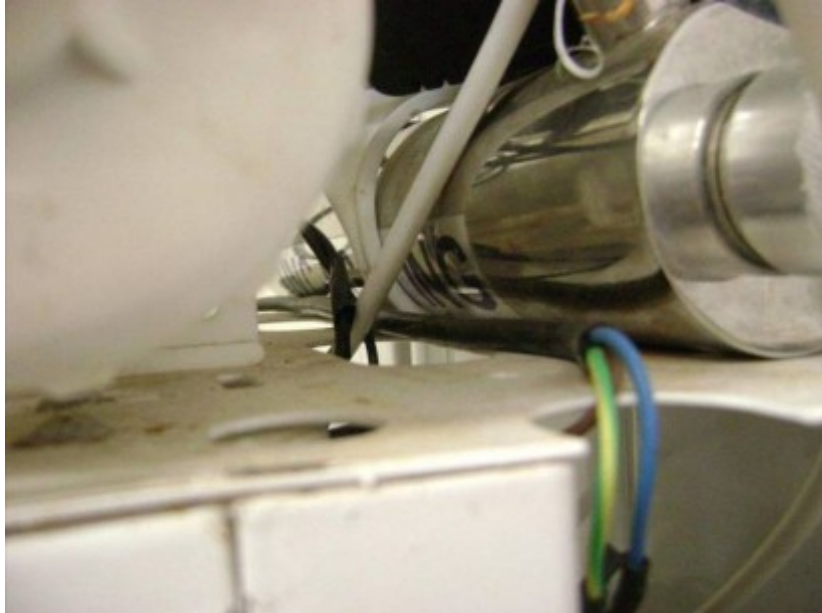
Εικόνα 28: Συσκευή UV-lighting ως τμήμα της διάταξης αντίστροφης ώσμωσης.
