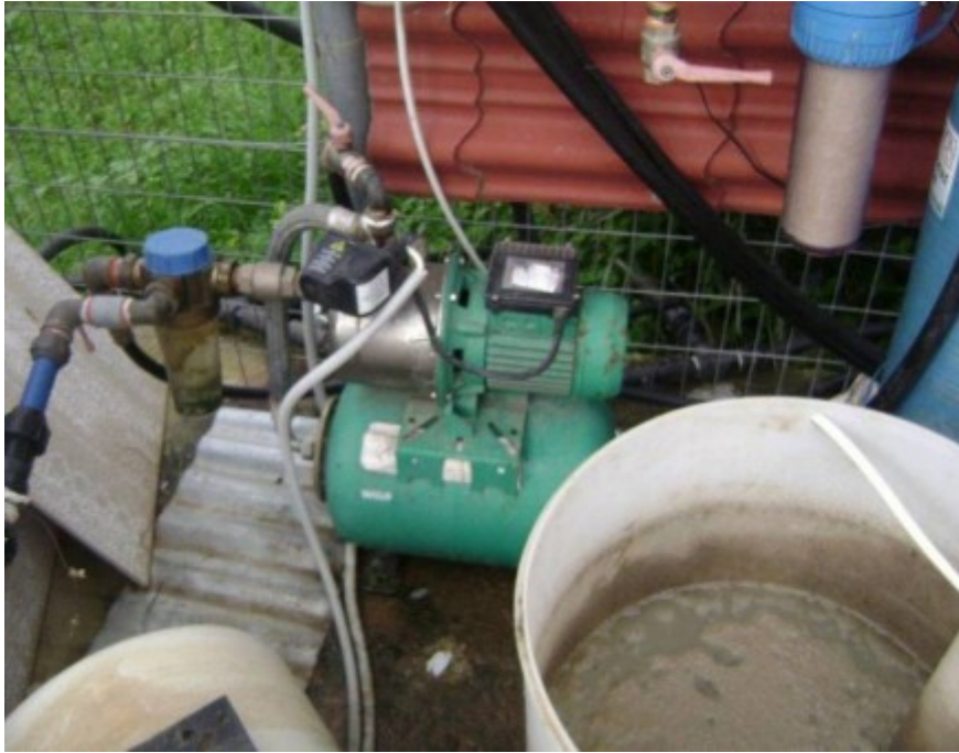
Εικόνα 17: Αντλία WILO, μοντέλο Wilo-MultiPress HMP 305.
