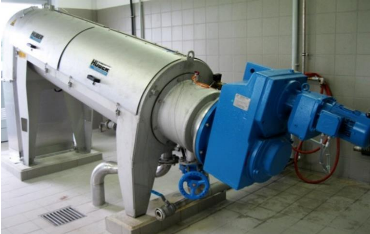
Εικόνα 3.8 Φυγοκεντρικός παχυντής
