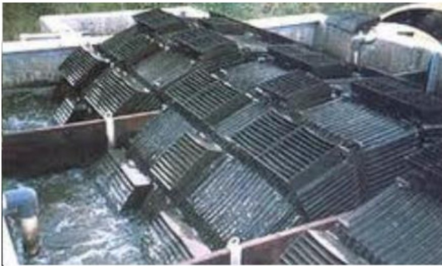
Εικόνα 2.2 Βιολογικός Δίσκος
