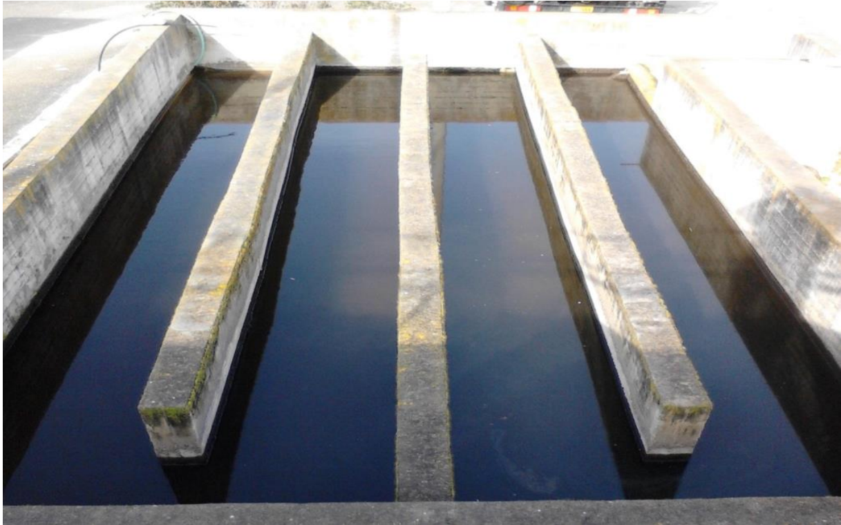
Εικόνα 4.31 Δεξαμενή χλωρίωσης
