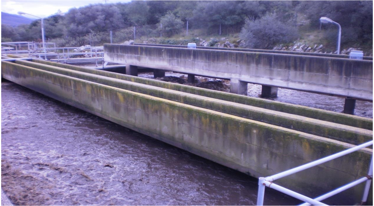
Εικόνα 4.17 Δεξαμενές αερισμού
