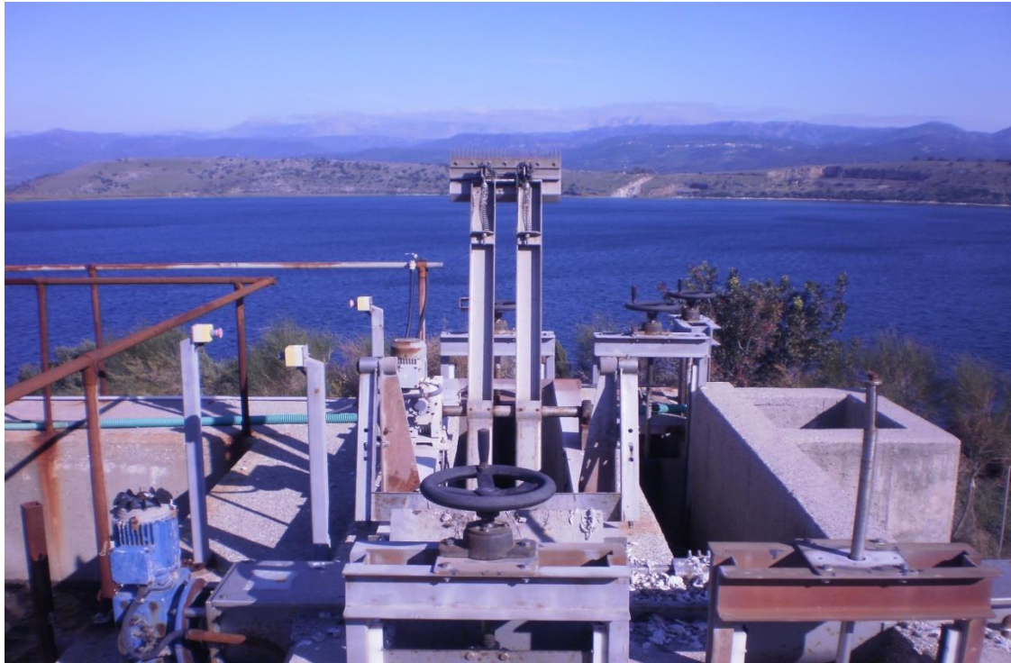
Εικόνα 4.4 Χώρος που γίνεται η εσχάρωση
