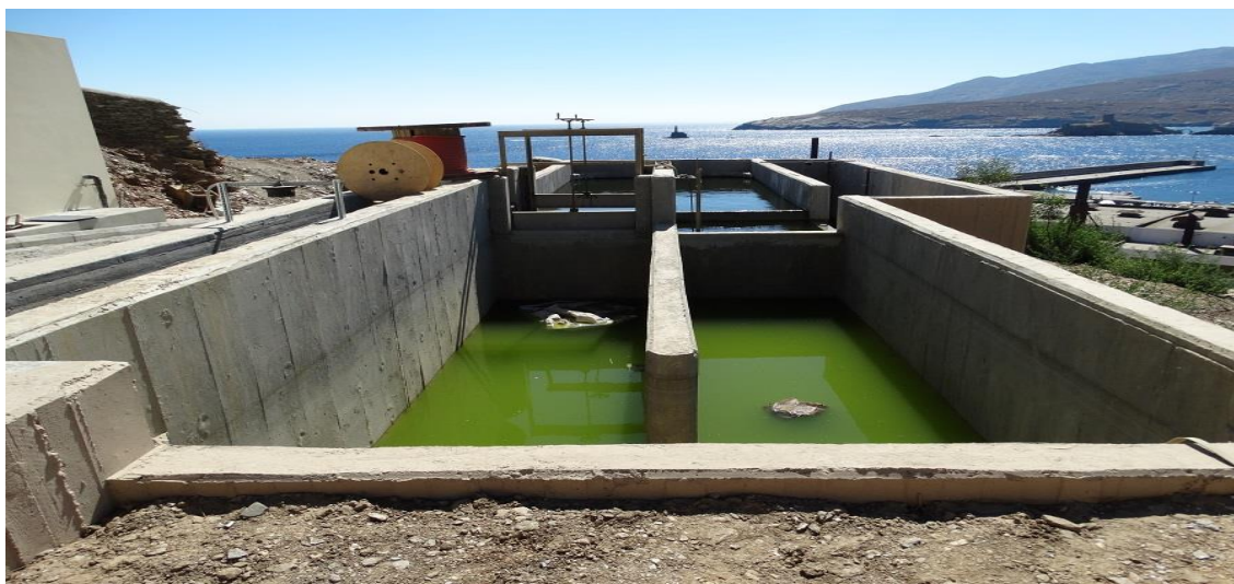
Εικόνα 3.11 Δεξαμενή χλωρίωσης από Ε.Ε.Λ. Σάμου
