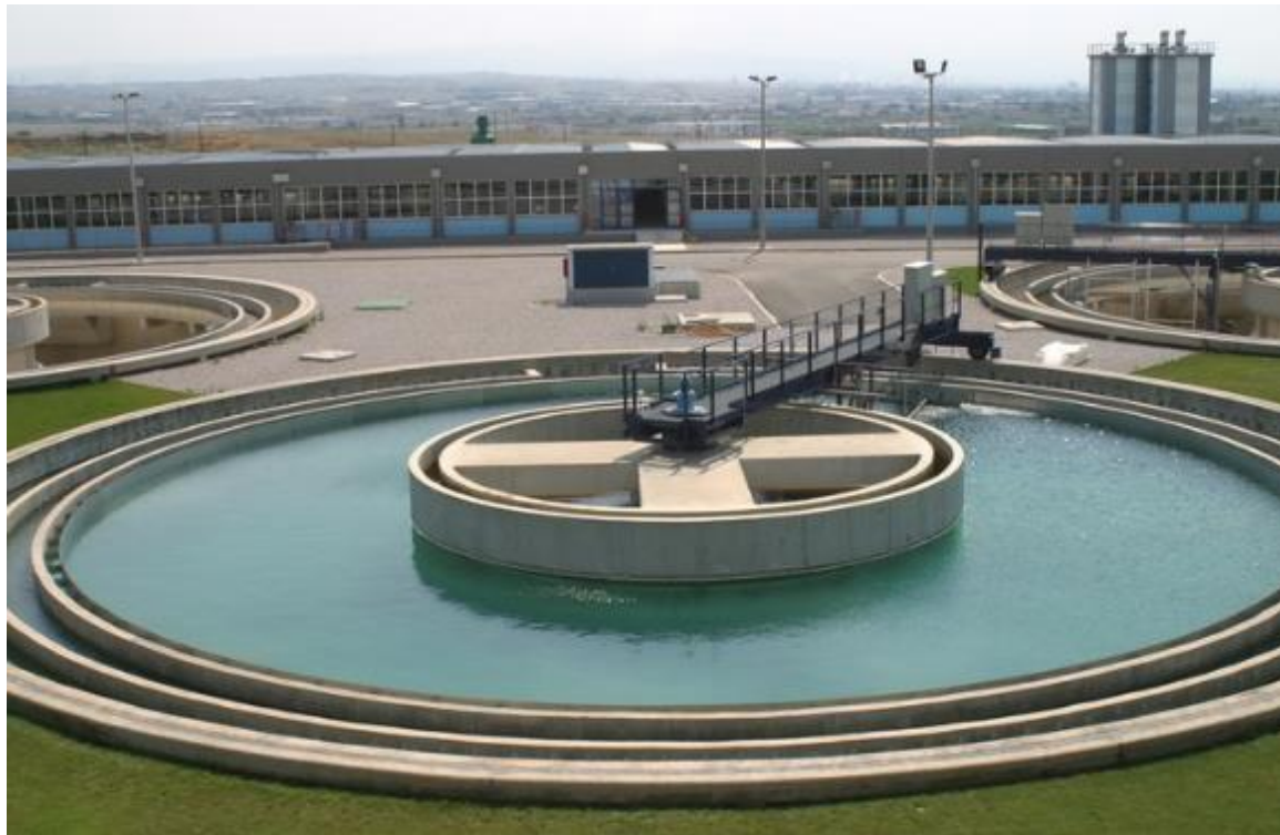
Εικόνα 3.3 Δεξαμενή καθίζησης
