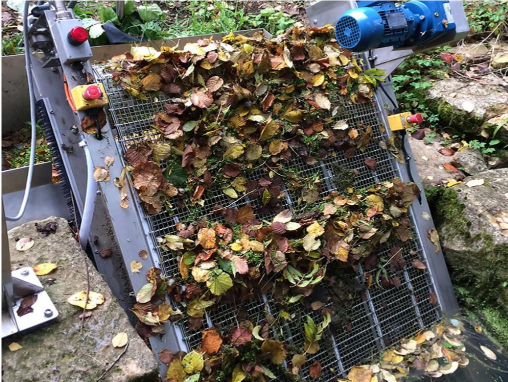
Εικόνα 3.2 Μηχανική αυτοκαθαριζόμενη εσχάρα
