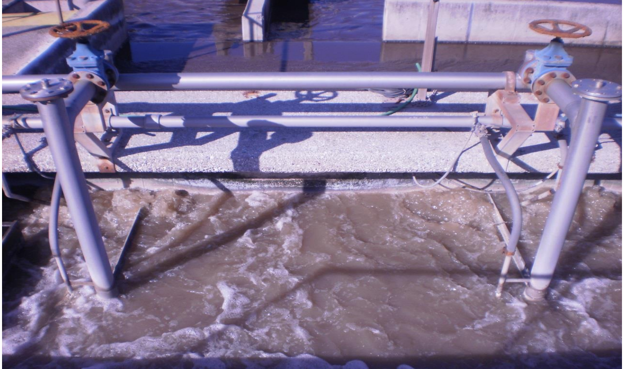
Πίνακας 4.12 : Αντλίες που μεταφέρουν άμμο που έχει καθιζάνει
