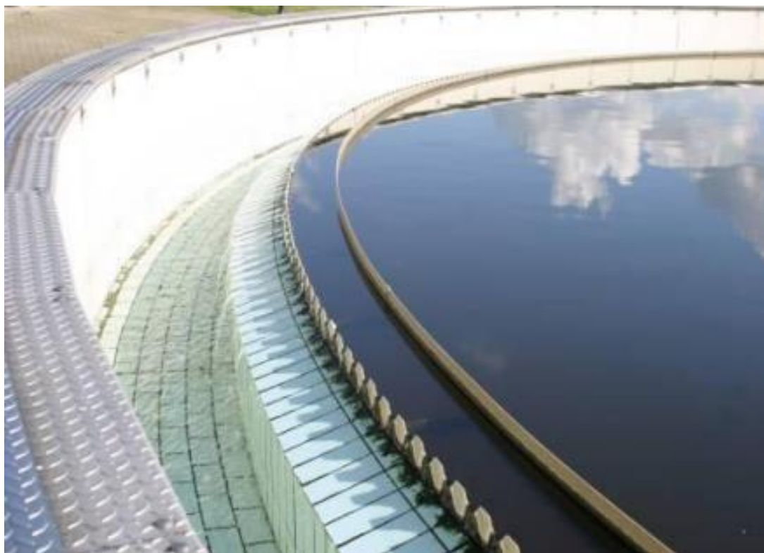
Εικόνα 3.4 Περιφερειακός οδοντωτός υπερχειλιστής
