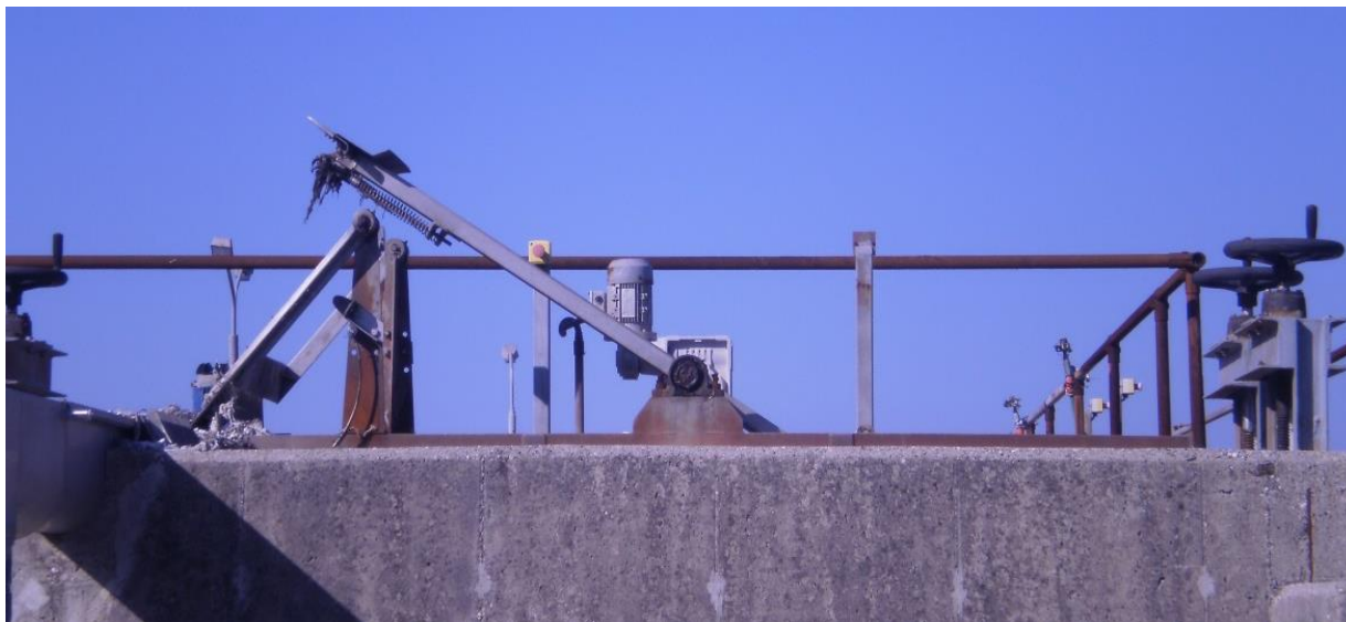
Εικόνα 4.6 Μηχανισμός καθαρισμού σχάρας
