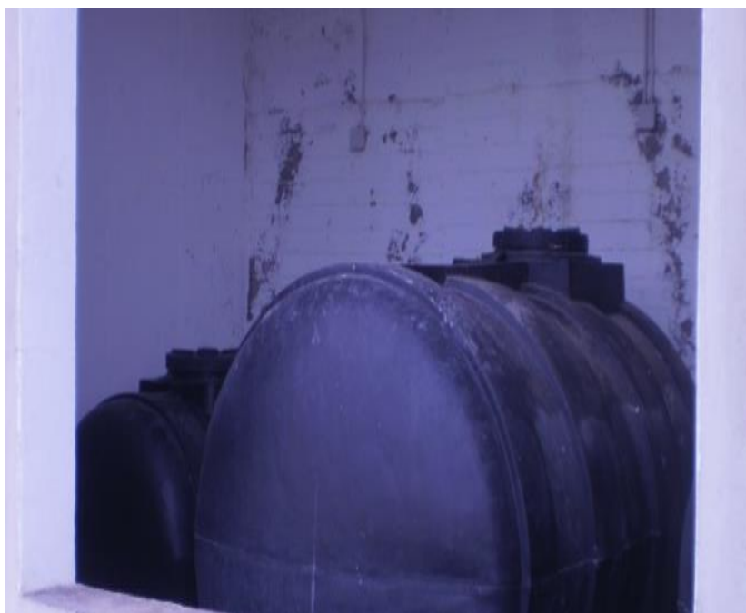
Εικόνα 4.30 Δοσομετρική Δεξαμενή
