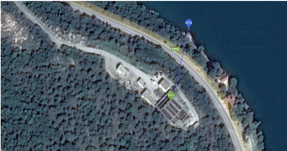
Εικόνα 4.32 Αποψη εγκατάστασης επεξεργασίας λυμάτων από ψηλά, καθώς και του ΑΠΔ : κατάληξη του χερσαίου τμήματος του αγωγού διάθεσης των επεξεργασμένων λυμάτων στον Αμβρακικό Κόλπο
