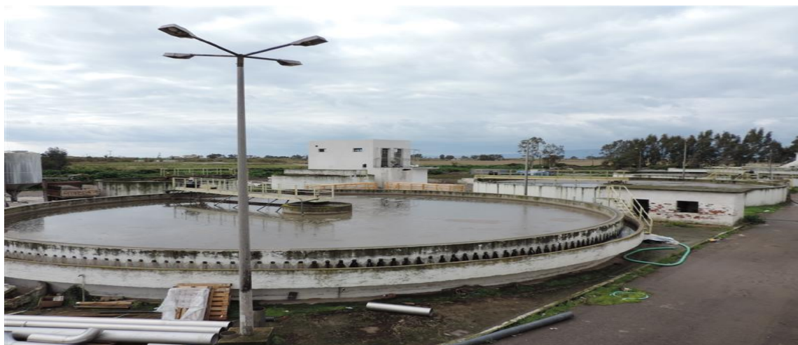
Εικόνα 3.5 Δεξαμενή τελικής καθίζησης
