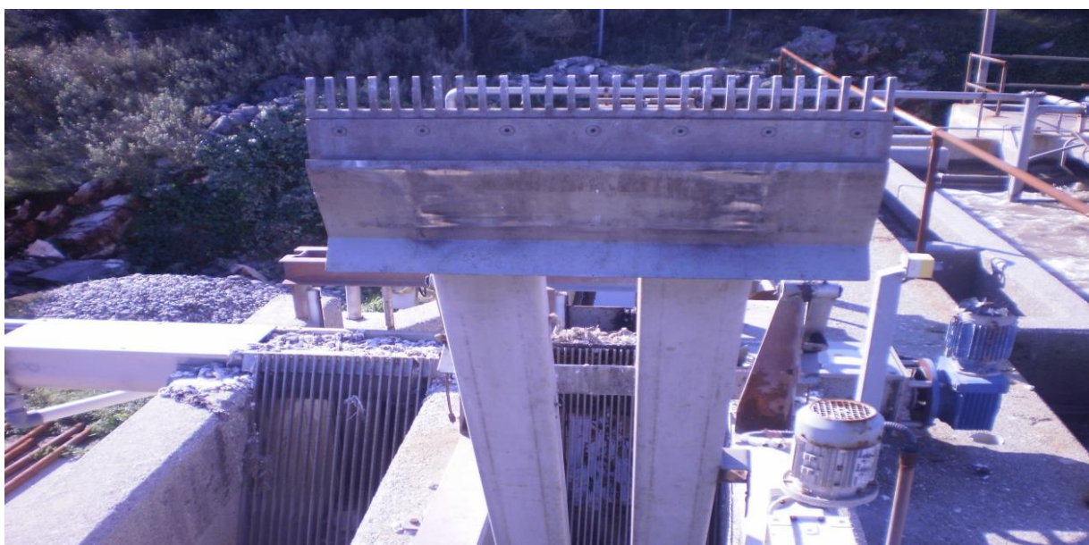
Εικόνα 4.5 Εσχάρωση
