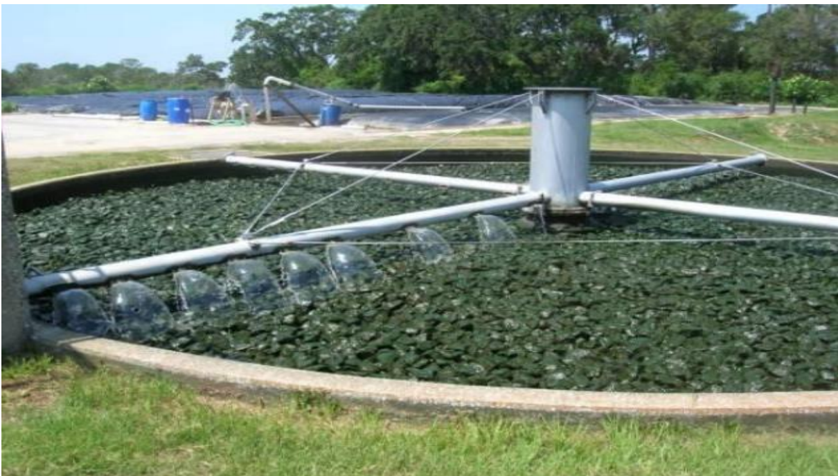
Εικόνα 2.1 Παραδοσιακό Σύστημα Χαλικοδιυλιστηρίου
