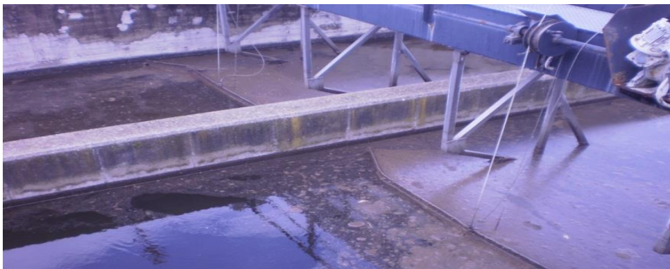
Εικόνα 4.22 σύστημα συγκέντρωσης των αφρών και των επιπλεόντων αντικειμένων
