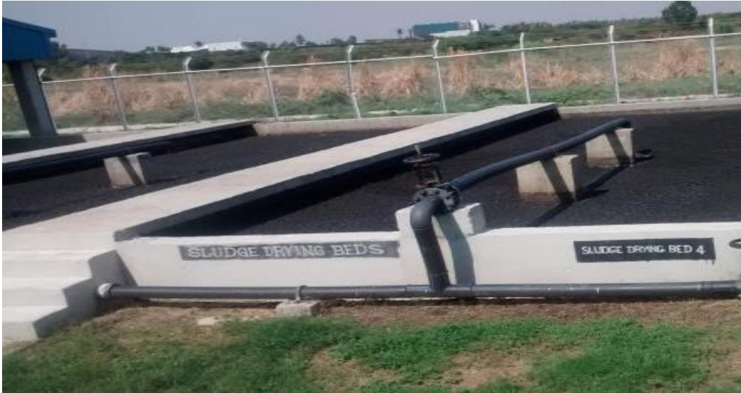
Εικόνα 3.10 Αφυδάτωση με κλίνες ξήρανσης
