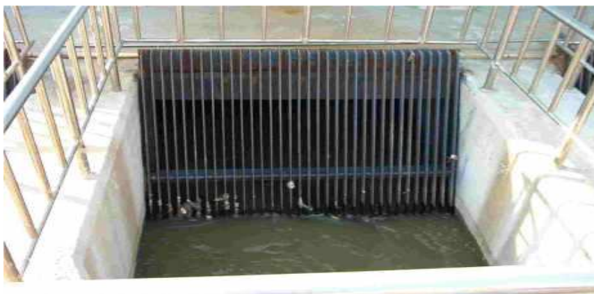
Εικόνα 3.1 Χειροκίνητη εσχάρα
