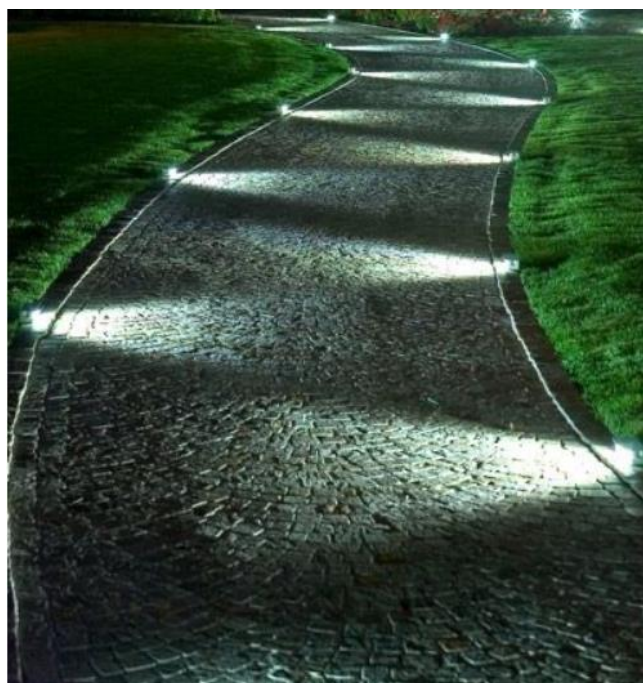
Εικόνα 6.5 Νυχτερινή απεικόνιση των διαδρόμων με φωτισμό Πηγή: Φωτιστικά - Καπέλα αμπαζούρ - Κατασκευές | Εργαστήριο - Fotistiko.gr
