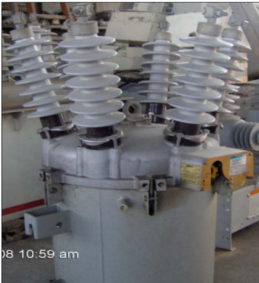
Κυλινδρικός Δ/ΑΕ τύπου KVVME
