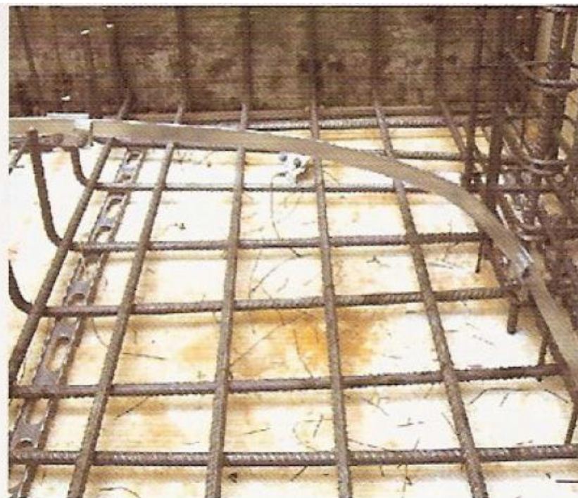
Βήμα 13. Αποφεύγουμε τα γωνιάσματα της ταινίας και σχηματίζουμε ανοιχτές καμπύλες. Στις θέσεις αυτές στηρίζουμε τον υπόλοιπο οπλισμό με δύο σφιγκτήρες, έναν πριν και ένα μετά την καμπύλη.
