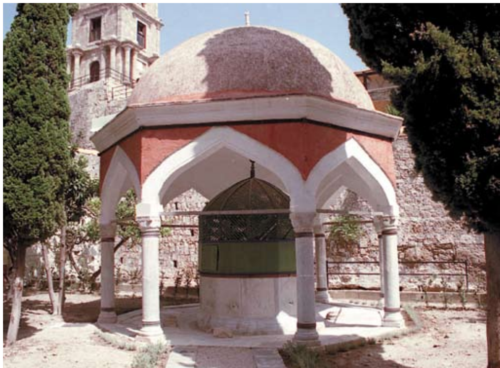
23. Η κρήνη μετά την αποκατάσταση. The ablutions fountain after restoration.
