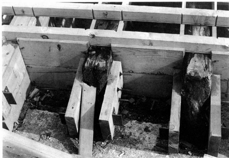
Εικ. 10: Λεπτομέρεια της στερέωσης των μεσαιωνικών οροφών
