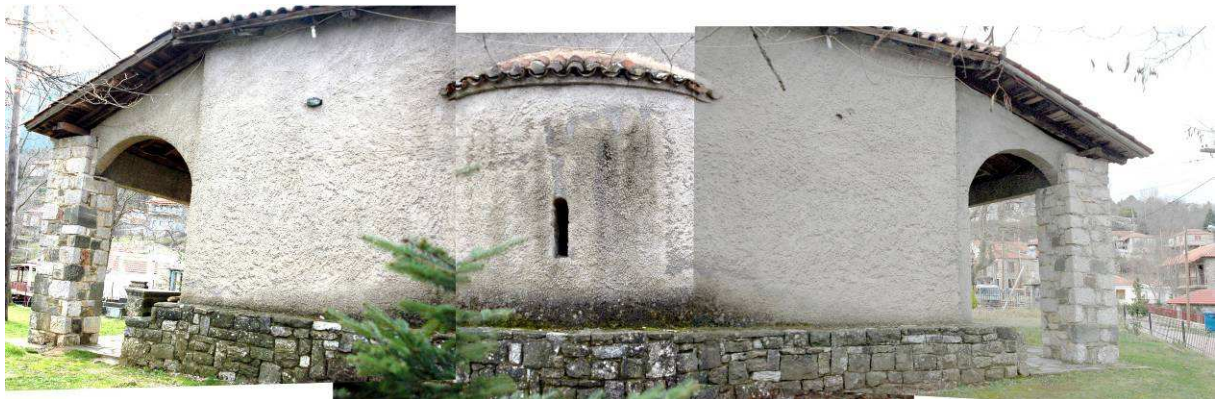
Εικ 17. Ανατολική Όψη του ναού. Διακρίνεται η τσιμεντοκονία που καλύπτει τους τοίχους.
