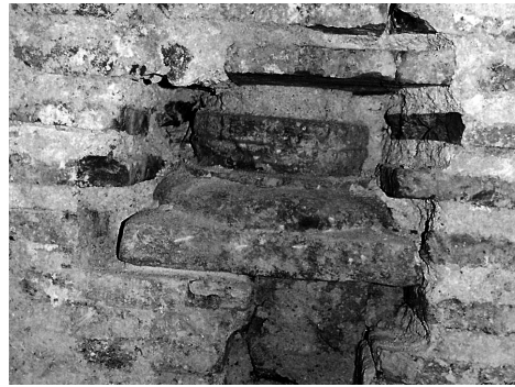
7. Μαρμάρινη βάση αμφικίονα από το δυτικό δίλοβο παράθυρο της νότιας τοιχοποιίας του φωταγωγού της Αχειροποιήτου εντοιχισμένη in situ στο ανώτερο τμήμα της τοξοστοιχίας του νότιου υπερώου.
