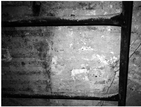
6. Τμήμα του δομικού αρμού μεταξύ των τοιχοποιιών του τεταρτοσφαιρίου της Α' και της Γ' οικοδομικής φάσης της κόγχης του ιερού βήματος.
