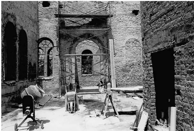
19. Εσωτερικό του χώρου Ι μετά από την καθαίρεση της οροφής (Ιούνιος 2006). Interior of the part I after the removal of the roof (June 2006).
