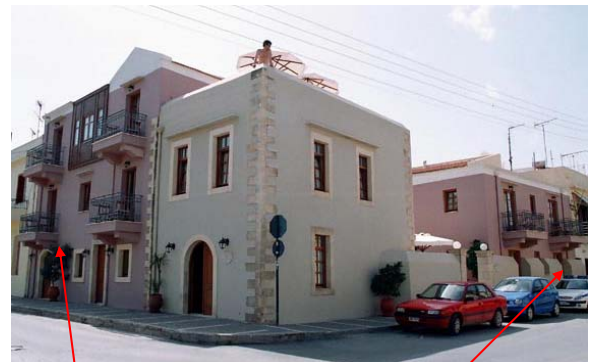
Εικ. 4. Νέα προσθήκη στο ΝΔ τμήμα. Παλιό τμήμα που ανακατασκευάστηκε.
