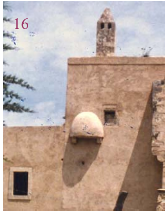
Εικ. 15. Στηθαίο νότιας πλευράς πριν από την επέμβαση, Εικ. 16: μετά την επέμβαση της Εφορείας, Εικ. 17. μετά την επέμβαση του Γ.Ε.Σ.
