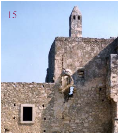
Εικ. 15. Στηθαίο νότιας πλευράς πριν από την επέμβαση, Εικ. 16: μετά την επέμβαση της Εφορείας, Εικ. 17. μετά την επέμβαση του Γ.Ε.Σ.
