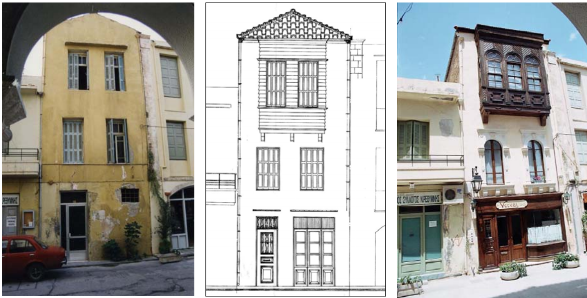
Εικ. 28,29, 30. Κτίριο στην Πλατεία Μητροπόλεως, στην οδό Καστρινογιαννάκη, πριν - κατά την διάρκεια - και μετά την επέμβαση.
