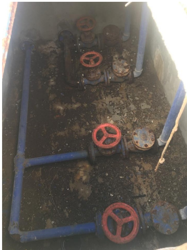
Εικόνα 14.10. Αντλίες στο αντλιοστάσιο ανακυκλοφορίας.
