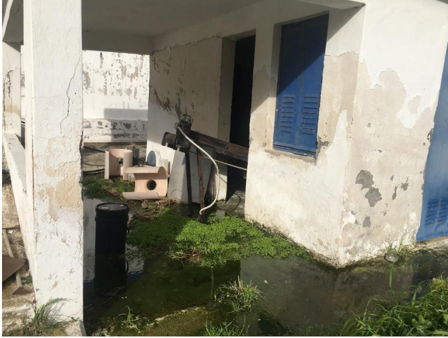
Εικόνα 14.13. Κτήριο επεξεργασίας υλούς.
