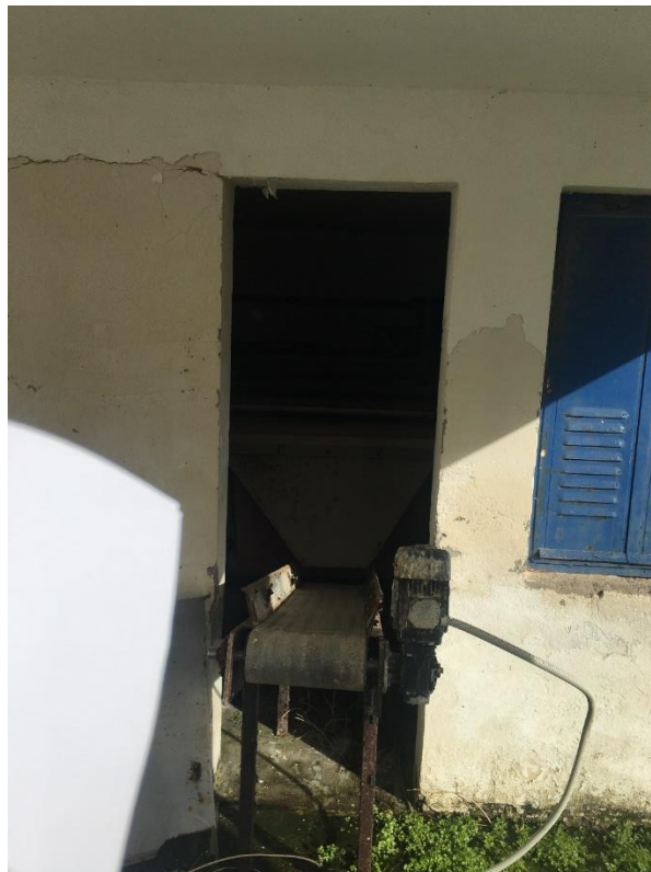
Εικόνα 14.12. Κτήριο επεξεργασίας ιλύος.
