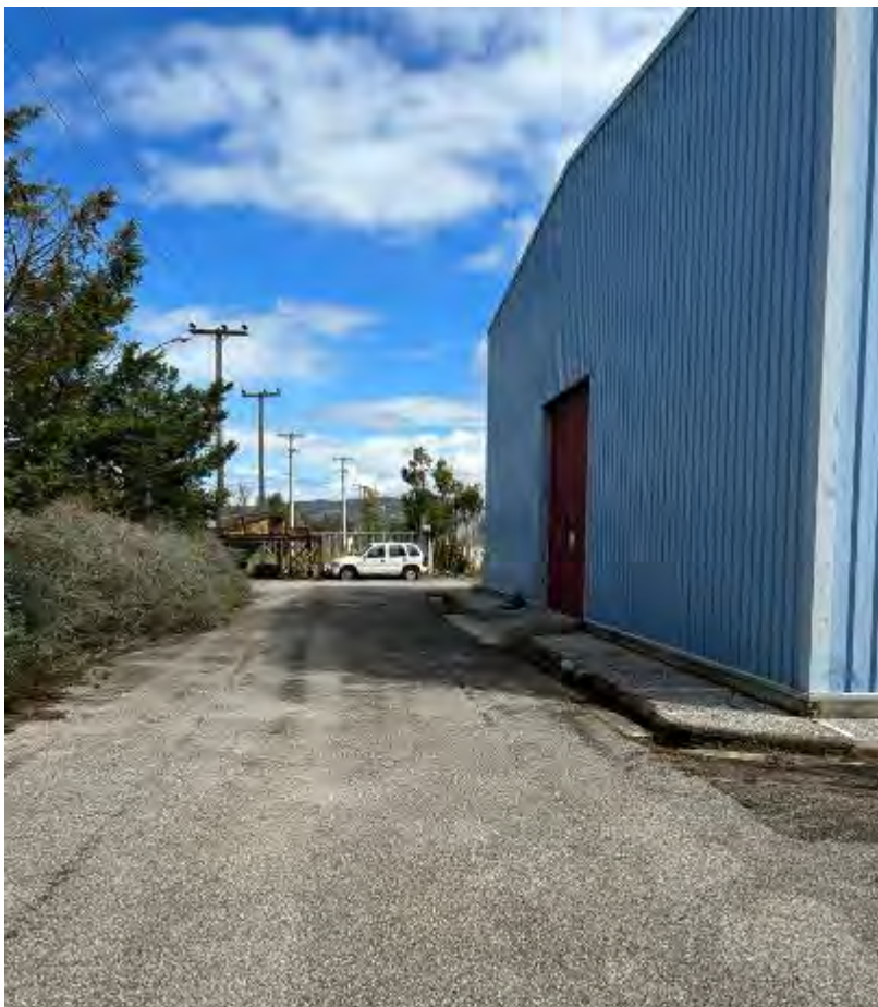
Φωτ. 3. Άποψη του βόρειου τμήματος του γηπέδου εγκατάστασης της μονάδας και των κτηριακών εγκαταστάσεων (Διοικητήριο - Γραφείο ασφάλειας- Κτίριο πολλαπλών χρήσεων).
