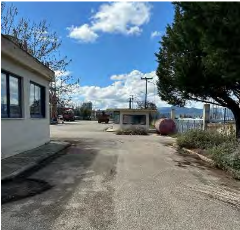
Φωτ. 2. Άποψη του δυτικού τμήματος και της εισόδου του γηπέδου εγκατάστασης της μονάδας.
