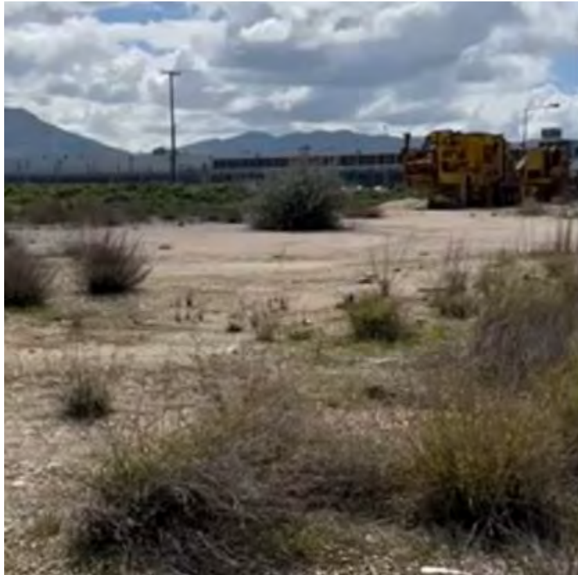
Φωτ. 4. Άποψη του νότιου τμήματος του γηπέδου εγκατάστασης της μονάδας.
