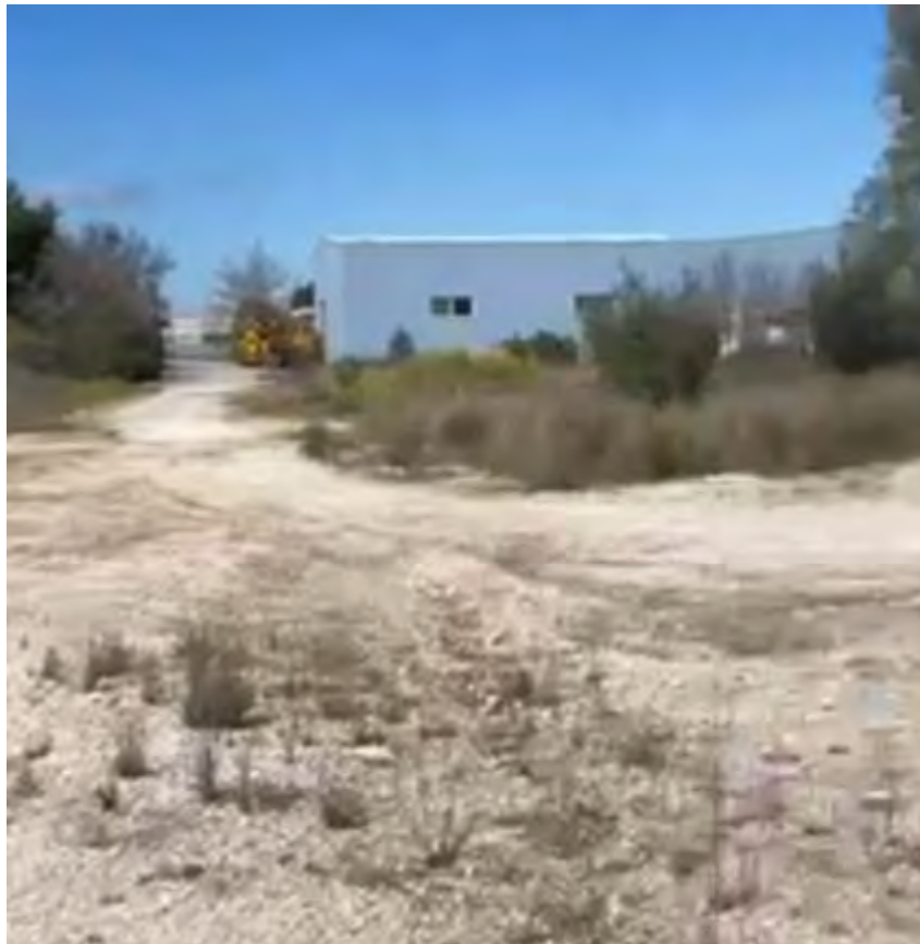
Φωτ. 5. Άποψη υφιστάμενων κτηριακών εγκαταστάσεων (Διοικητήριο - Γραφείο ασφάλειας- Κτίριο πολλαπλών χρήσεων) από ανατολικά.
