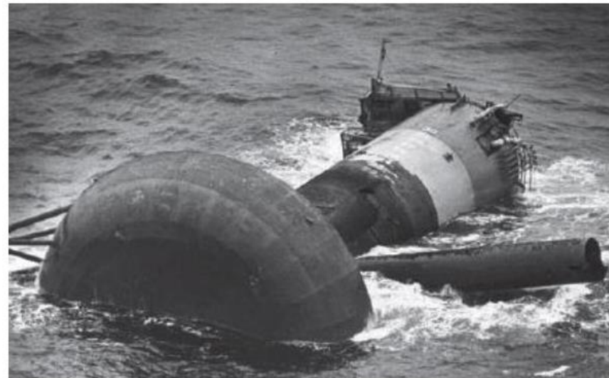
Σχήμα 3: (α) Η πλατφόρμα Alexander Kielland, (β) ένα από τα υποστυλώματα επιπλέει μετά την κατάρρευση της πλατφόρμας τον Μάρτιο του 1980
