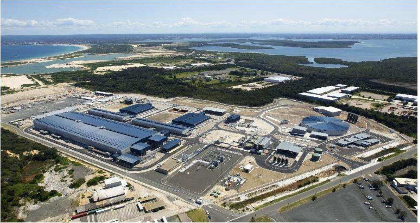
Εικόνα 36 : Αεροφωτογραφία της μονάδας αφαλάτωσης στο Kurnell του Σίδνεϋ
