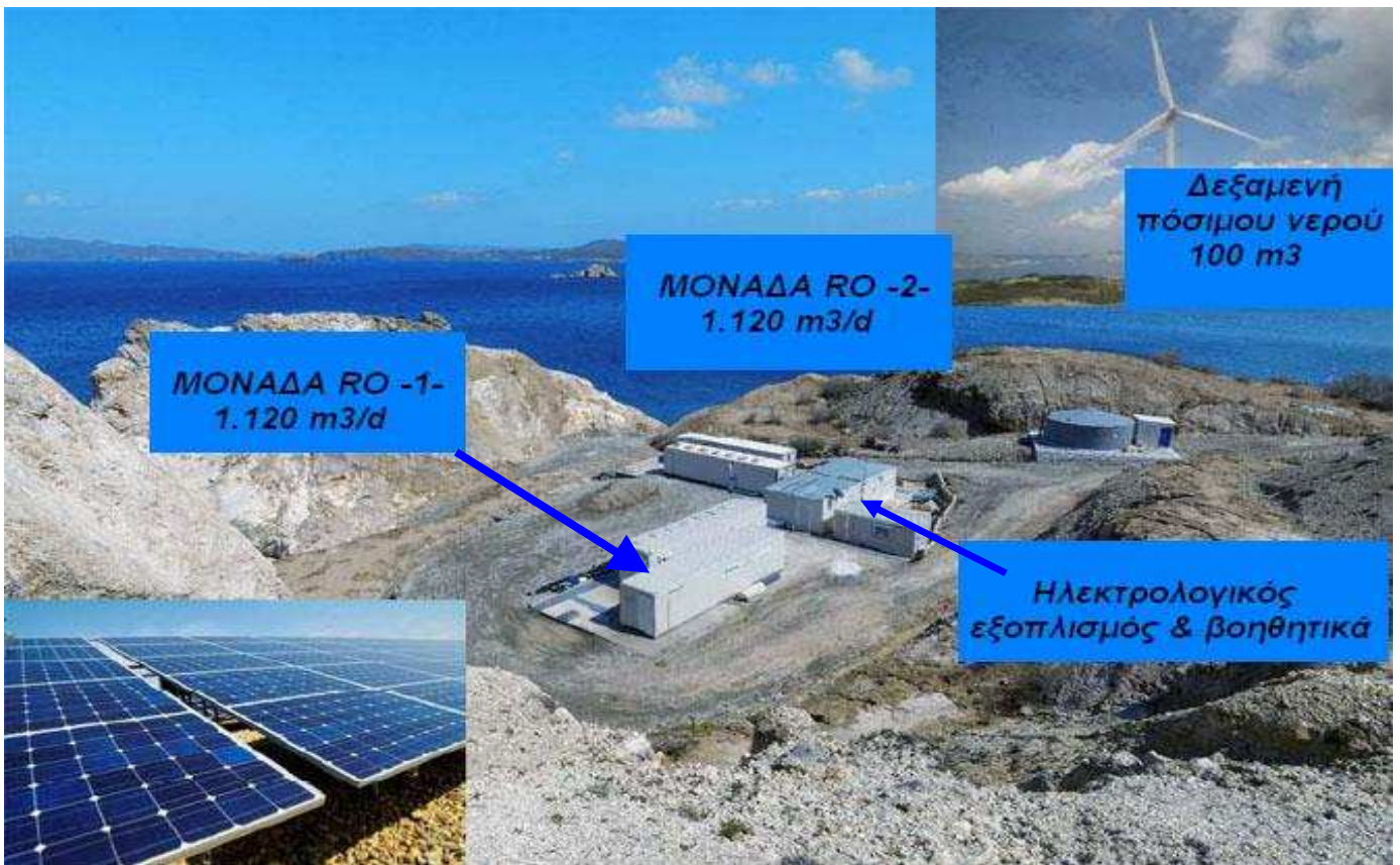
Εικόνα 44 : Εγκαταστάσεις της μονάδας αφαλάτωσης Μήλου
