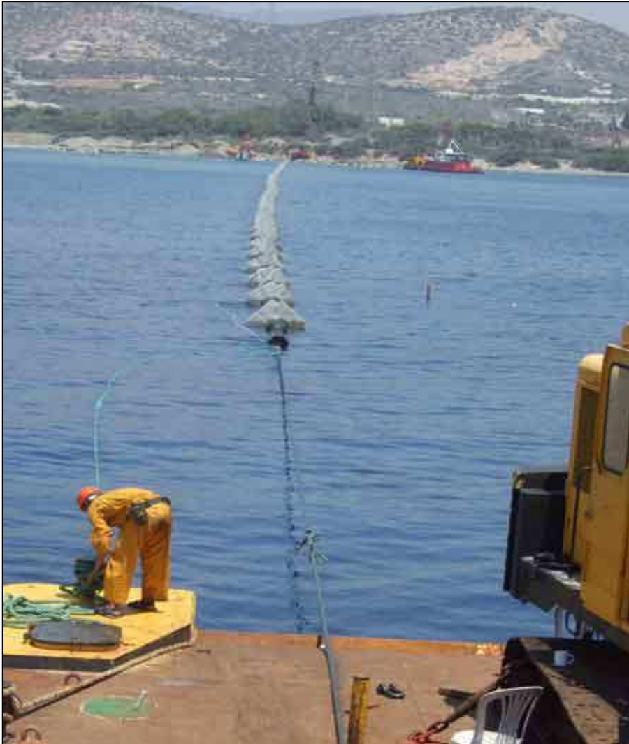
Εικόνα 74 : Τοποθέτηση αγωγού απόρριψης άλμης, Κύπρος
