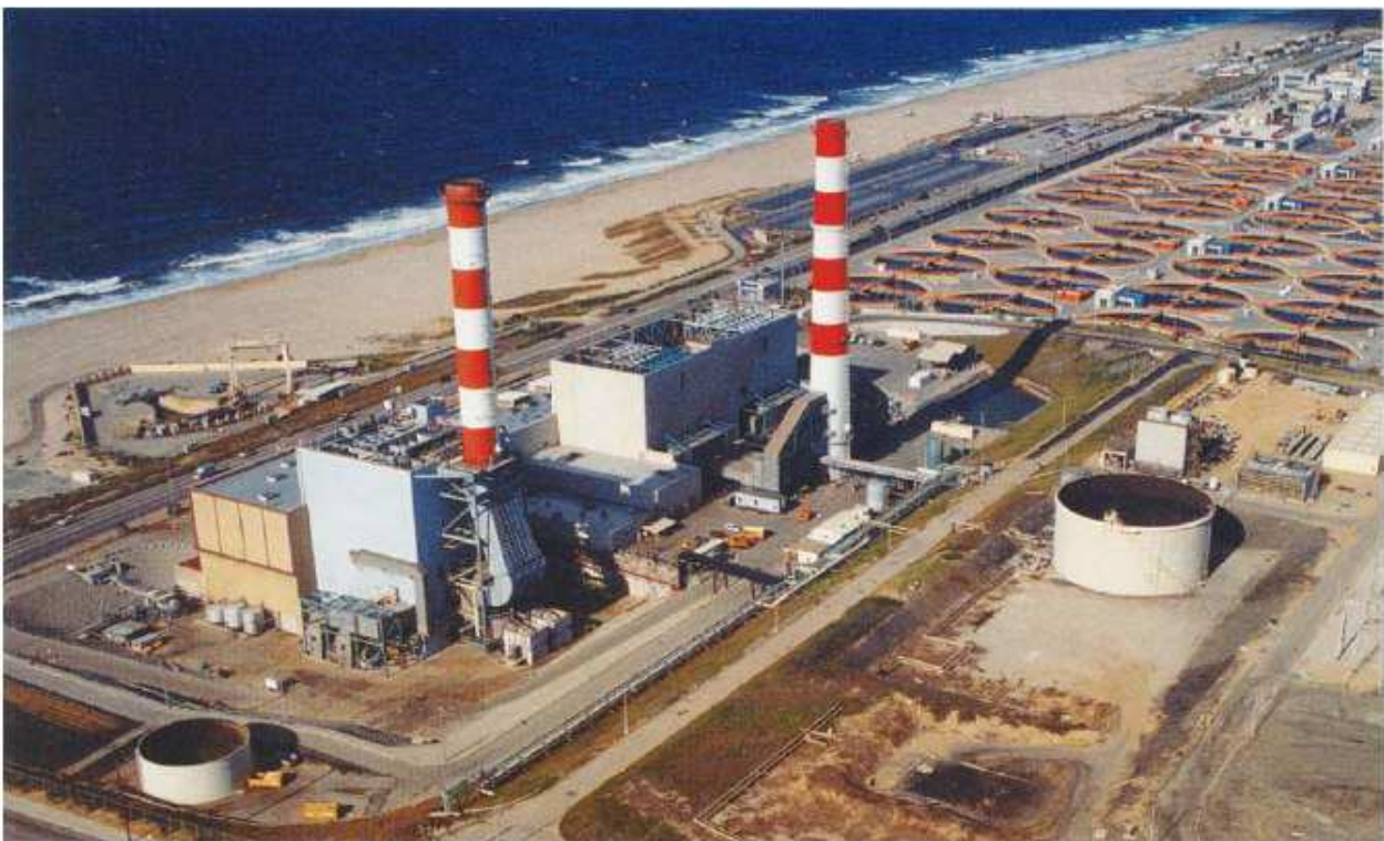
Εικόνα 42: Φωτογραφία του εργοστασίου αφαλάτωσης Escondido που βρίσκεται στη νότια Ακτή της Καλιφόρνια.
