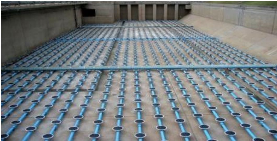
Εικόνα 2.10: Σύστημα αερισμού (β).
