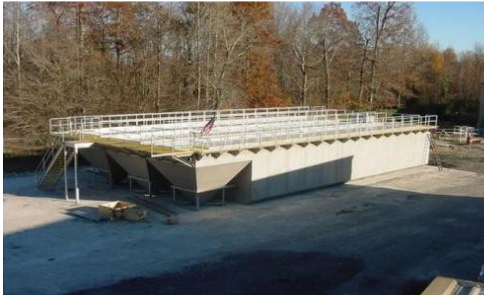
Εικόνα 2.3: Προκατασκευασμένες εγκαταστάσεις επεξεργασίας λυμάτων.
