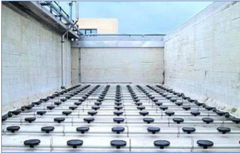
Εικόνα 1.11: Διαχυτές Αερισμού Λυμάτων Μεμβράνης.
