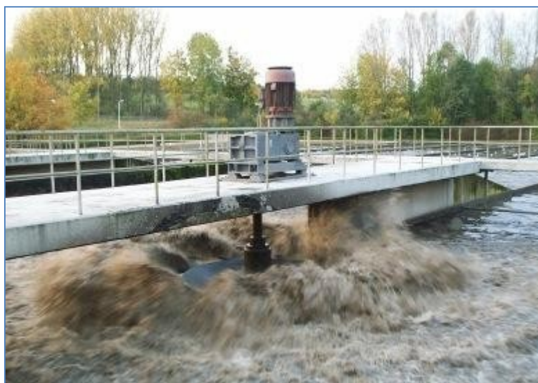
Εικόνα 1.13: Κατακόρυφοι Επιφανειακοί Αεριστήρες από Χάλυβα.
