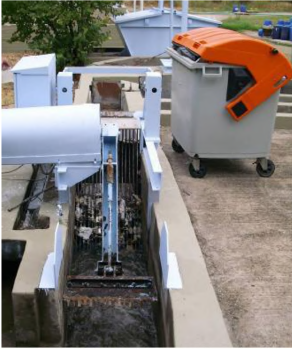
Εικόνα 3.1 Εσχάρα μηχανική-αυτοκαθαριζόμενη
