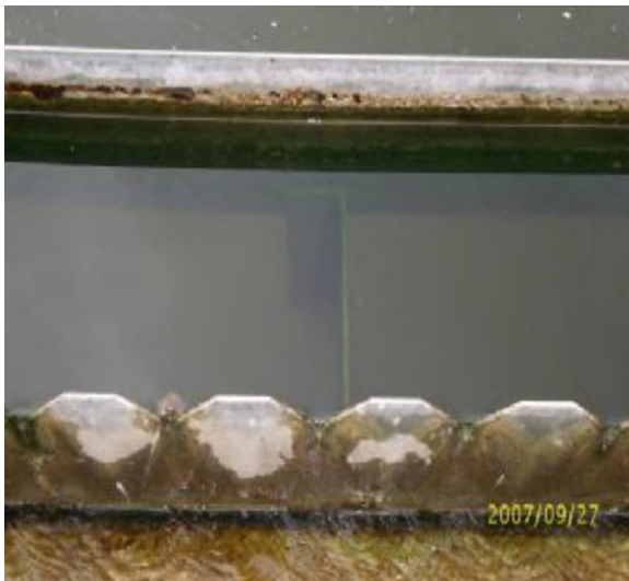
Εικόνα 3.8 Περιφερειακός οδοντωτός υπερχειλιστής
