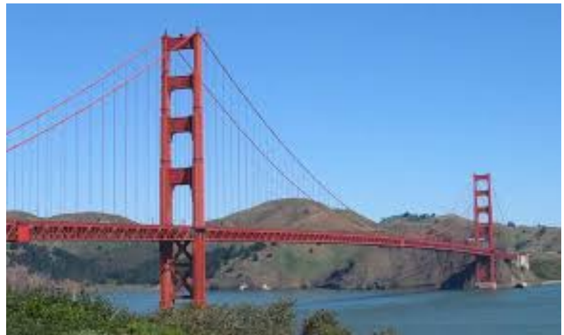
Γέφυρα Golden Gate με ηλώσεις
