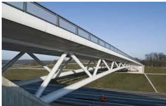
Γέφυρα με συγκολλημένες δοκούς
