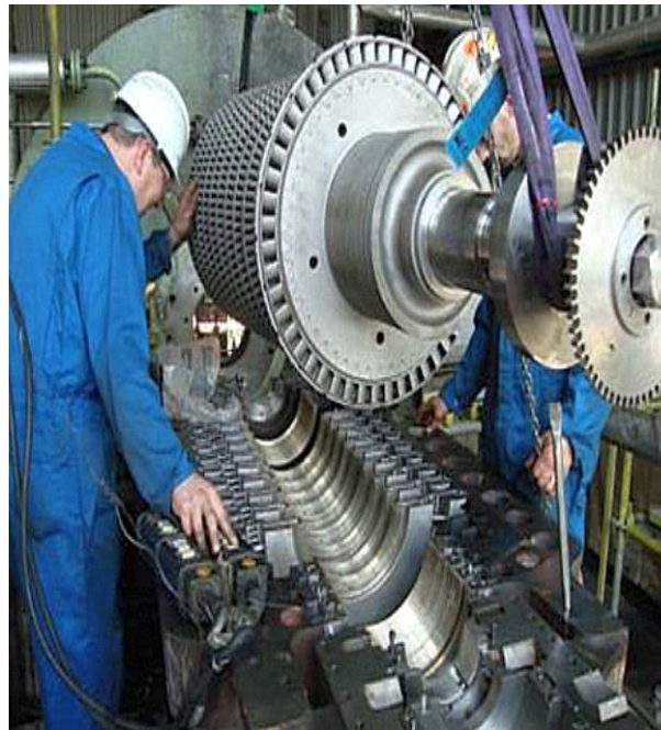
Τοποθέτηση στροφείου ατμοστρόβιλου
