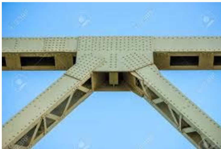
Κοχλίωση δοκών Γεφύρας
