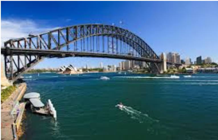
Γέφυρα Σίδνεϋ με ηλώσεις
