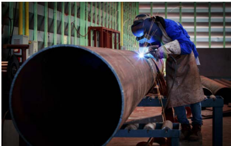
Ηλεκτροσυγκόλληση σωλήνα δια χειρός
