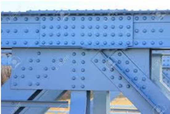
Ήλωση δοκών Γεφύρας
