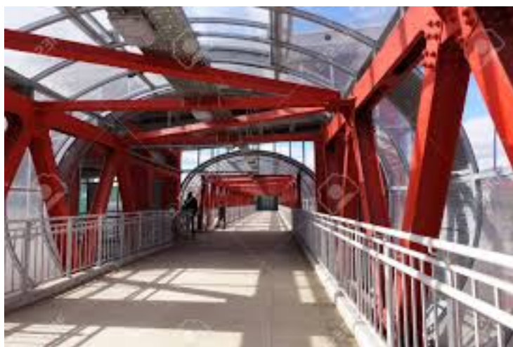
Γέφυρα με κοχλιώσεις
