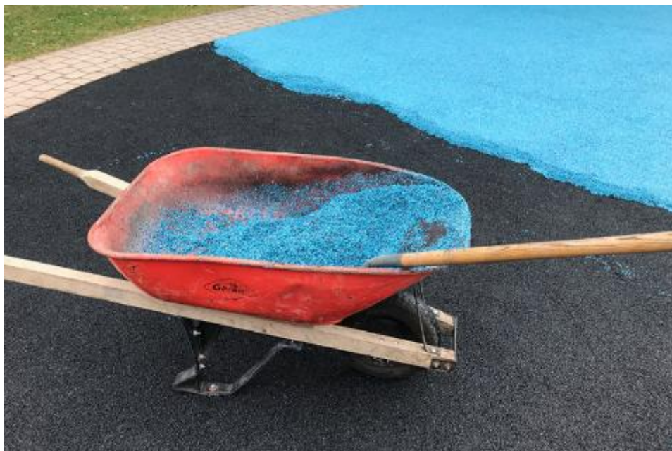
Εικόνα 27 Pour-in-Place Rubber Flooring
