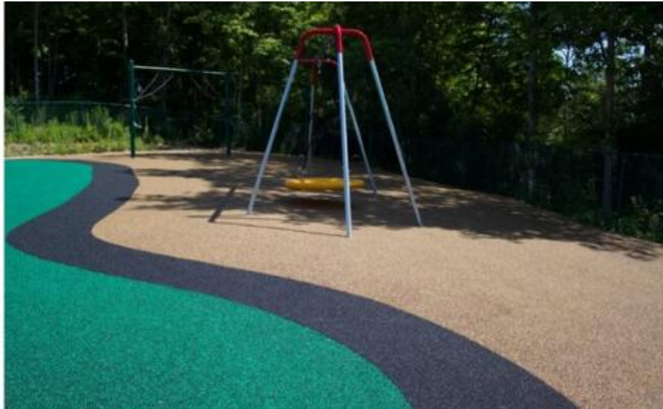
Εικόνα 26 Pour-in-Place Rubber Flooring
