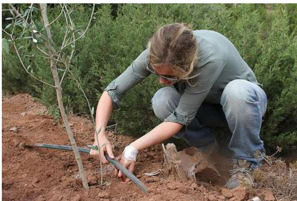
Εγκατάσταση συστήματος στάγδην άρδευσης με λάστιχα μέσα στο έδαφος.
